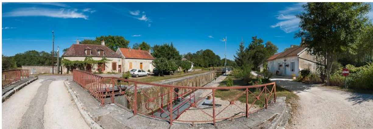
Vue d'ensemble du site d'écluse avec, de gauche à droite, la maison de garde et la maison éclusière avec annexe. 89, Ancy-le-Franc, lieudit : bief 80 du versant Yonne
