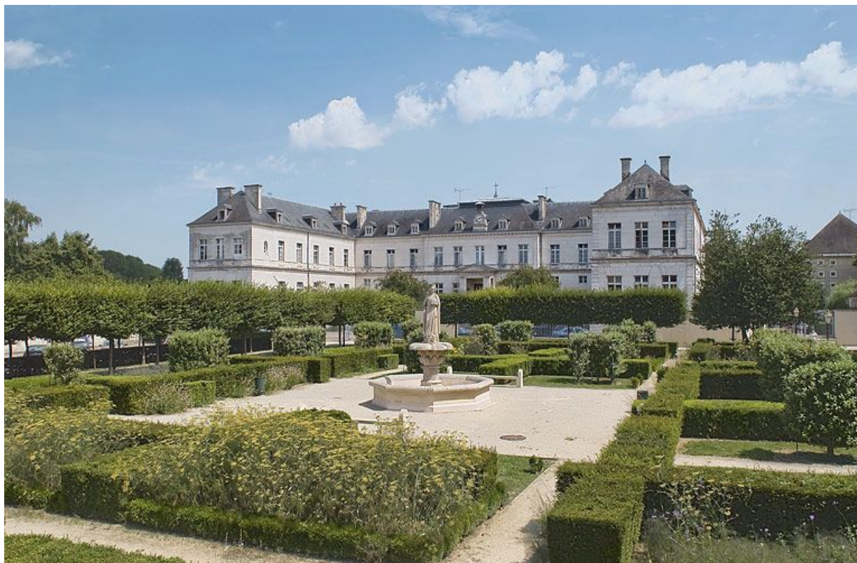
Pavillon Dormois : vue d'ensemble de la façade antérieure.
