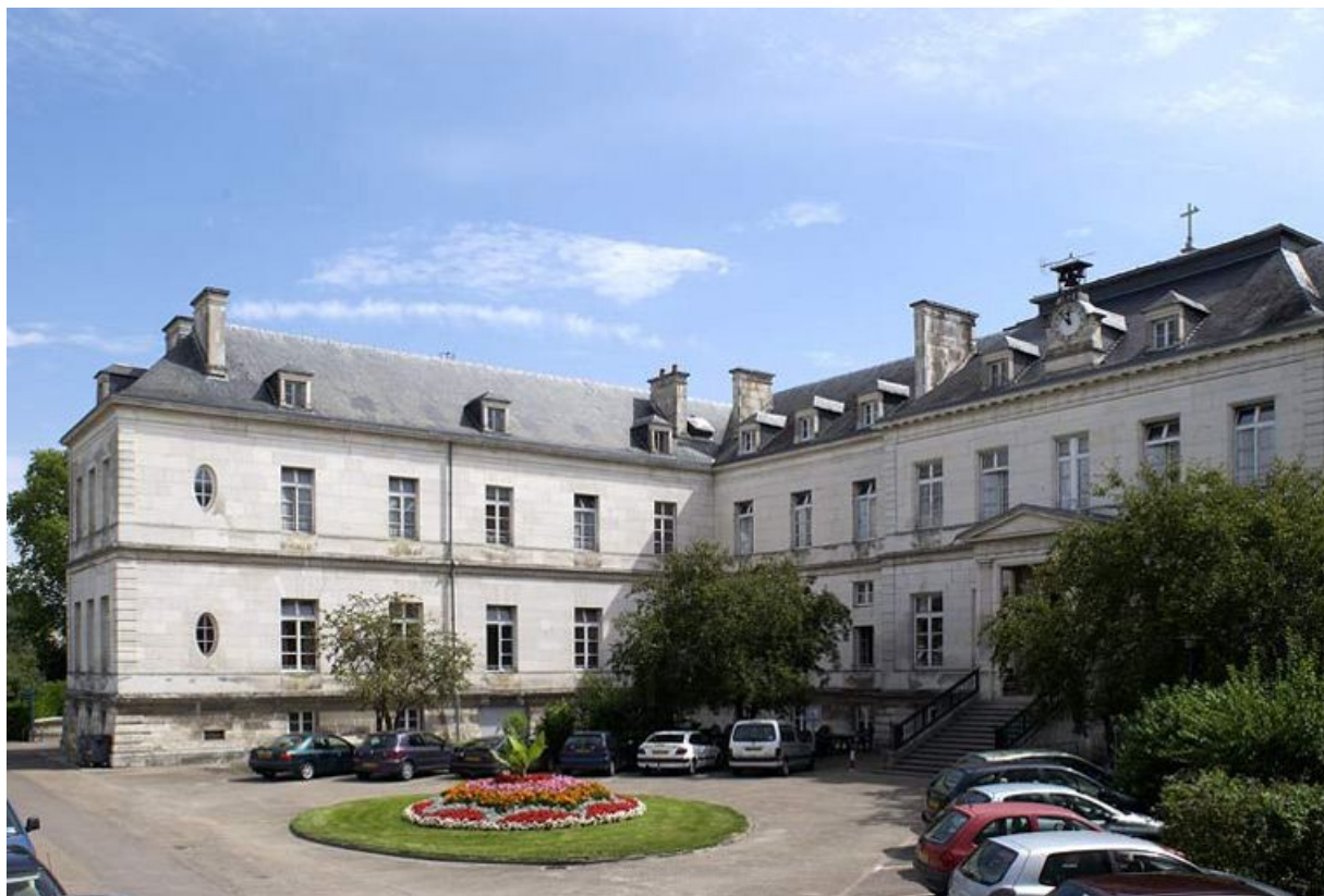
Pavillon Dormois : vue partielle du corps central et aile nord dévolue aux femmes. 89, Tonnerre Hôpital
