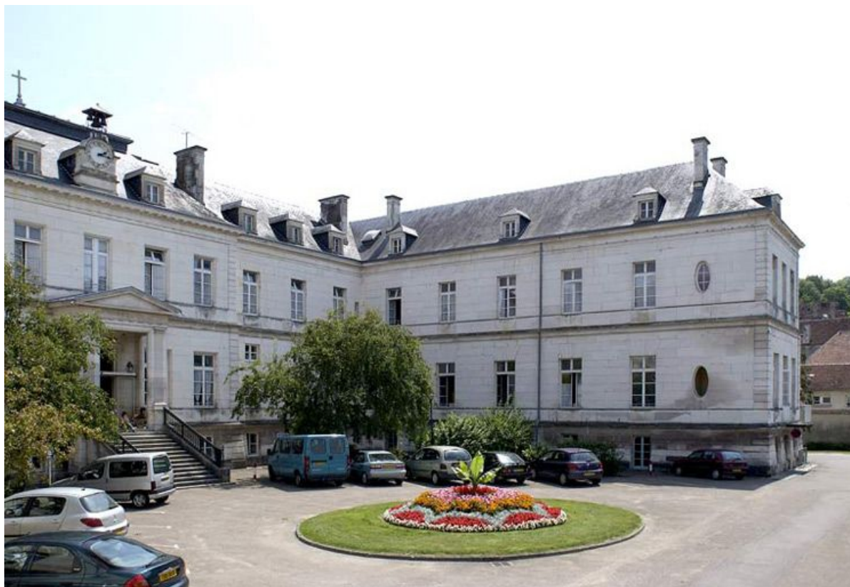
Pavillon Dormois : vue partielle du corps central et aile sud dévolue aux hommes. 89, Tonnerre Hôpital
