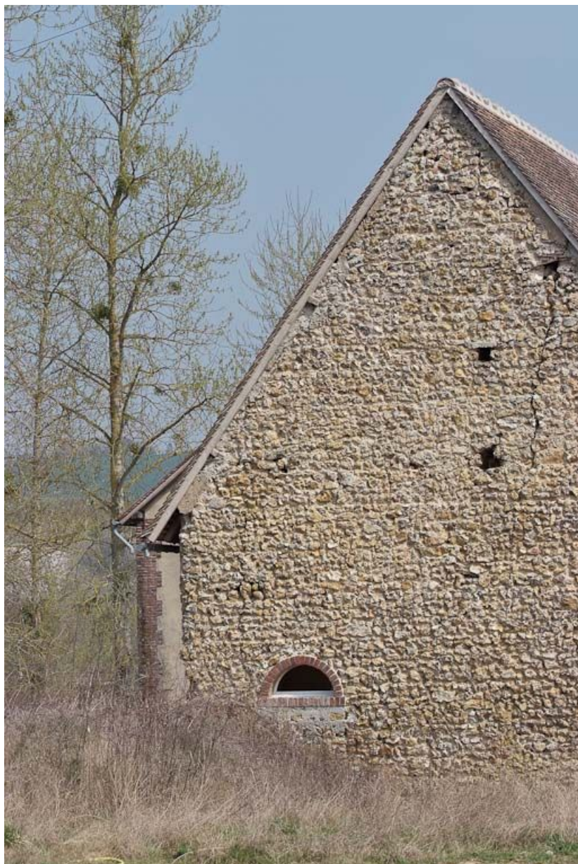
Mur-pignon du bâtiment à gauche en entrant, appareil en silex.
