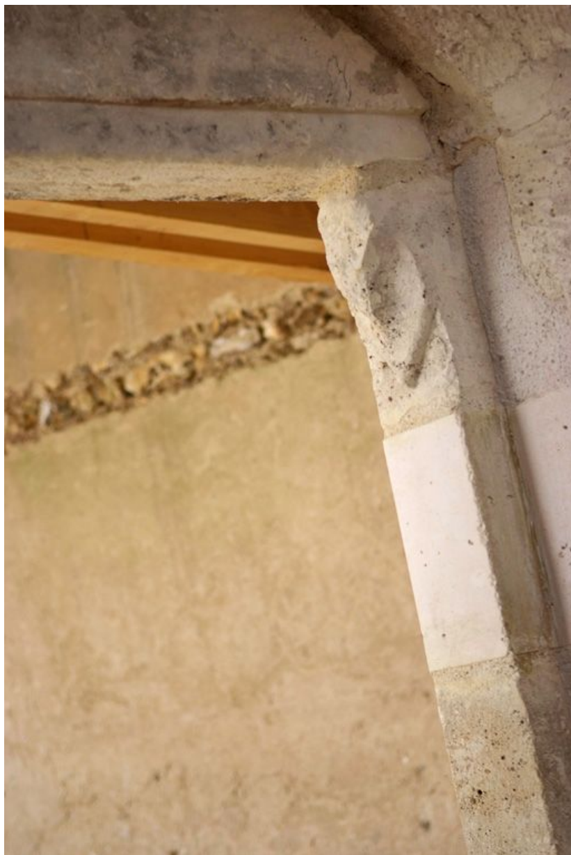
Détail du coussinet de l'ouverture dans le mur sud de la chapelle.
