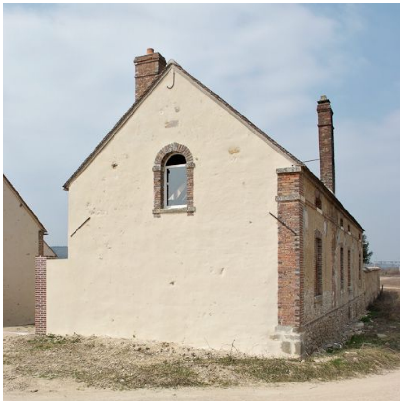
Mur-pignon et façade postérieure du bâtiment à droite en entrant.
