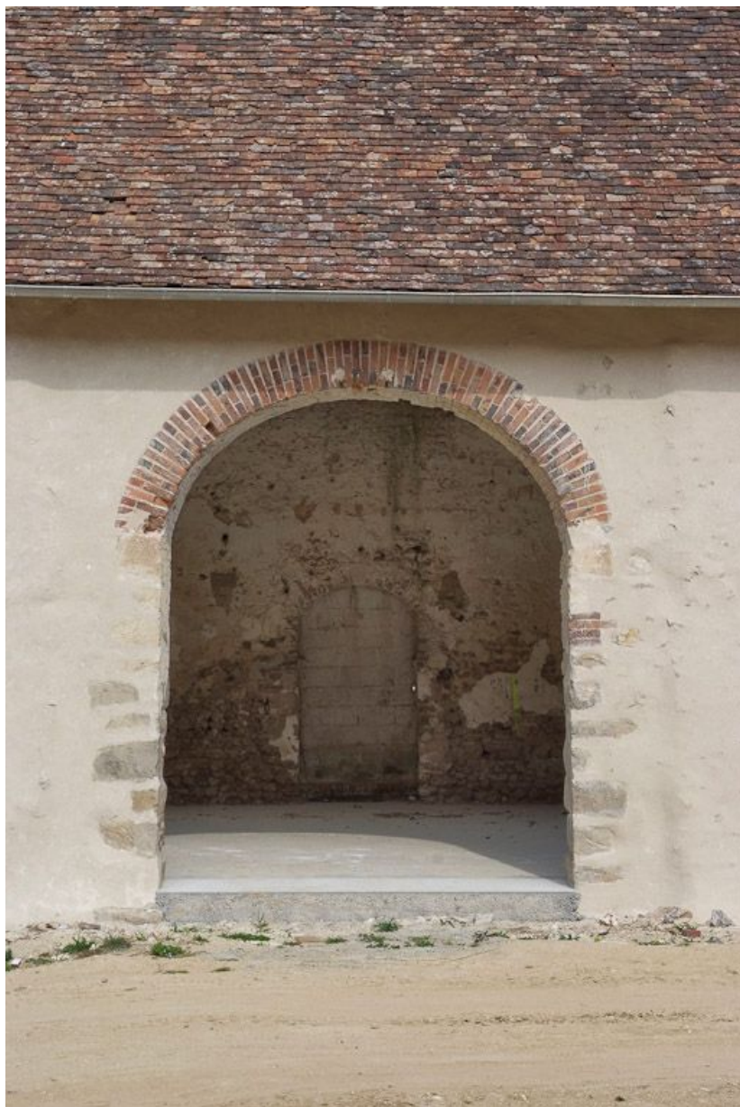
Porte charretière du 1er bâtiment à gauche en entrant dans la cour.
