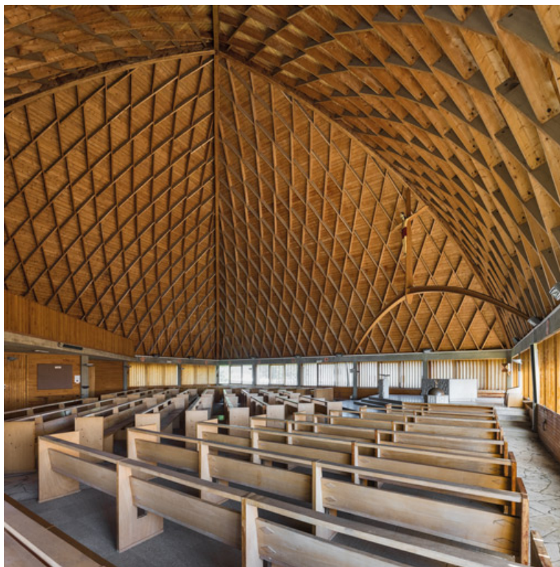
Nef. Vue depuis l'angle sud en direction du nord-est.
