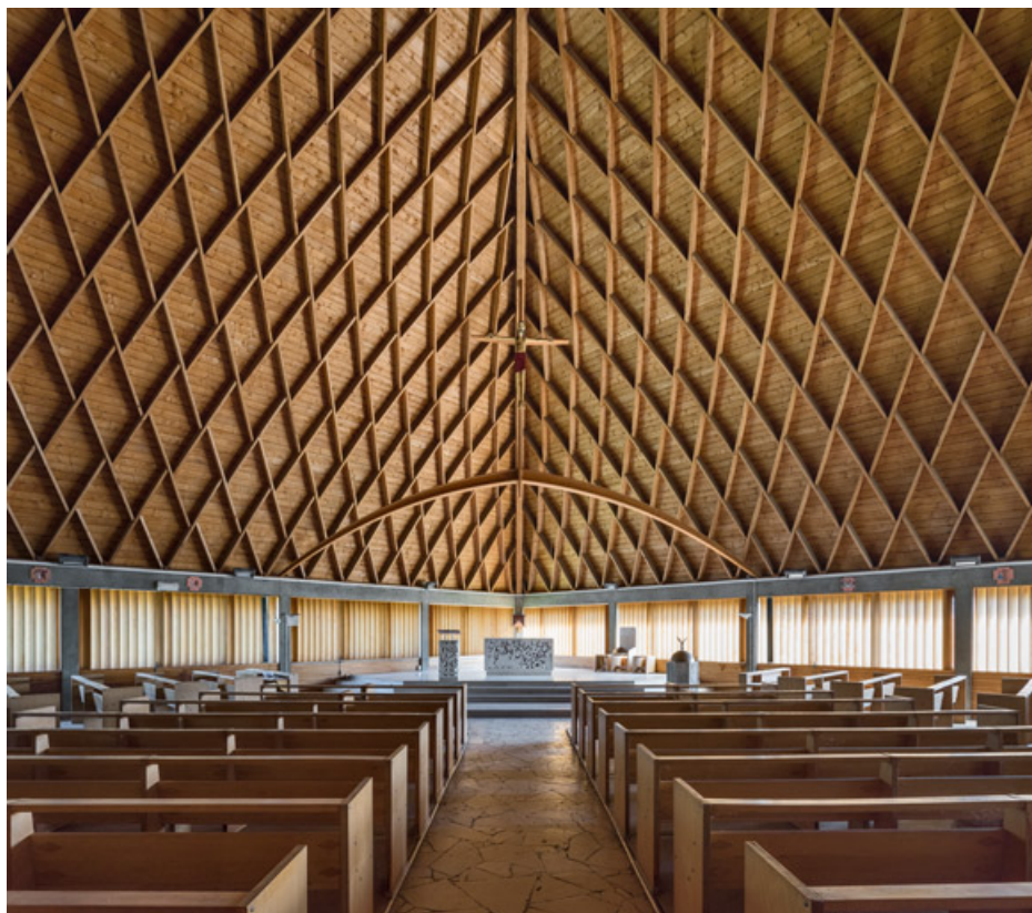
Chœur. Vue depuis l'allée centrale.
