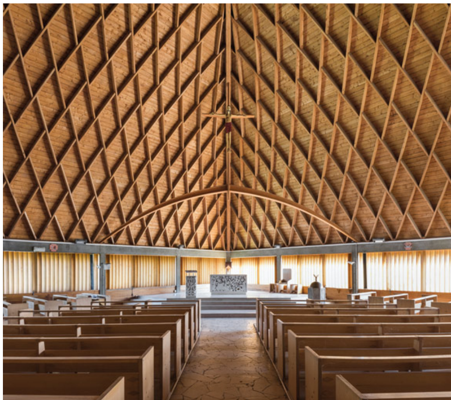
Chœur. Vue depuis l'allée centrale.
