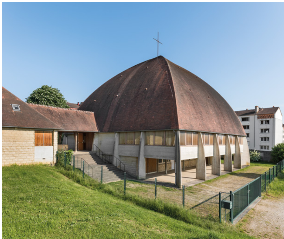
Eglise. Vue de trois quarts depuis le sud.
