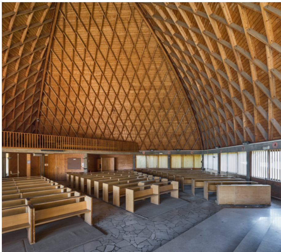
Nef. Vue en direction du nord-ouest.
