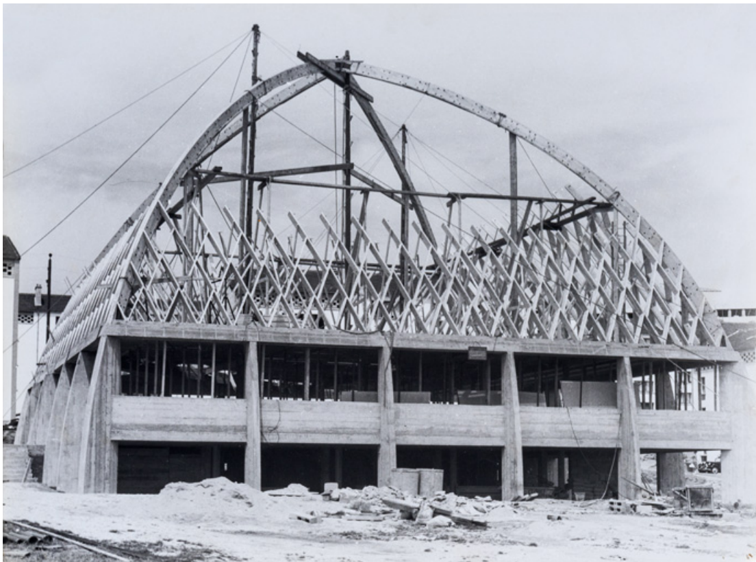
Pose de la charpente de l'église Sainte-Thérèse des Rosoirs, 1958.
