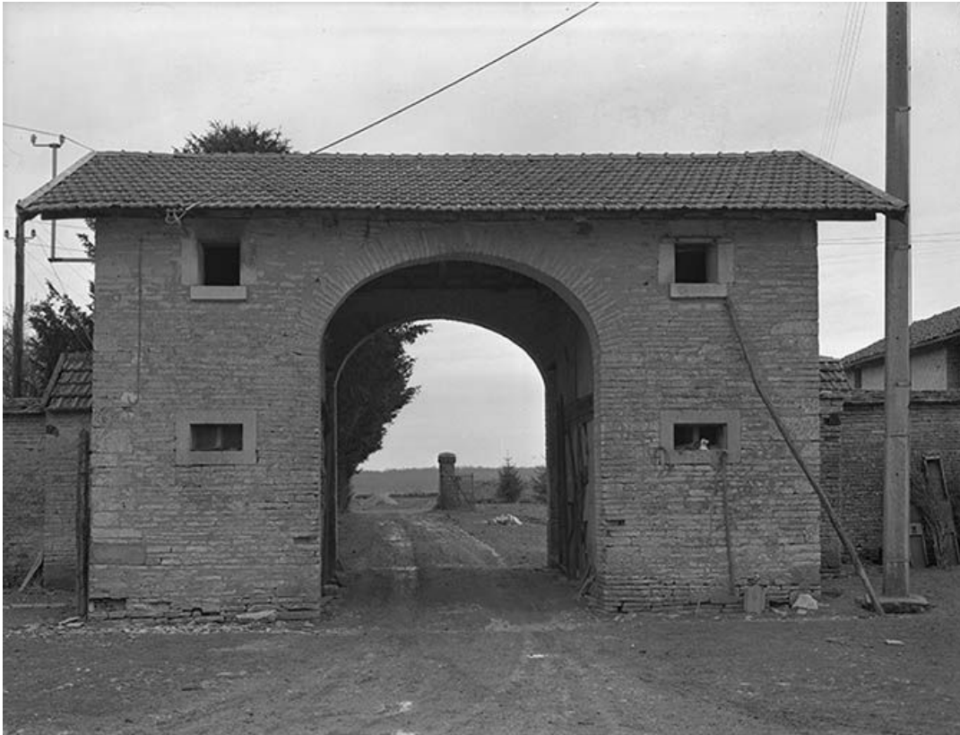
Ferme sise parcelle F1, du cadastre de 1958 : porche. 89, Vireaux
