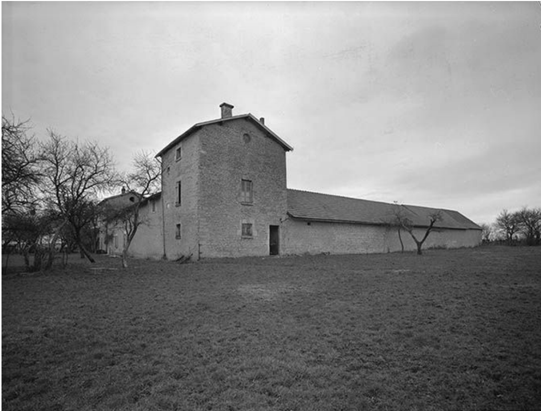
Vue de la ferme prise à l'extérieur des bâtiments.
