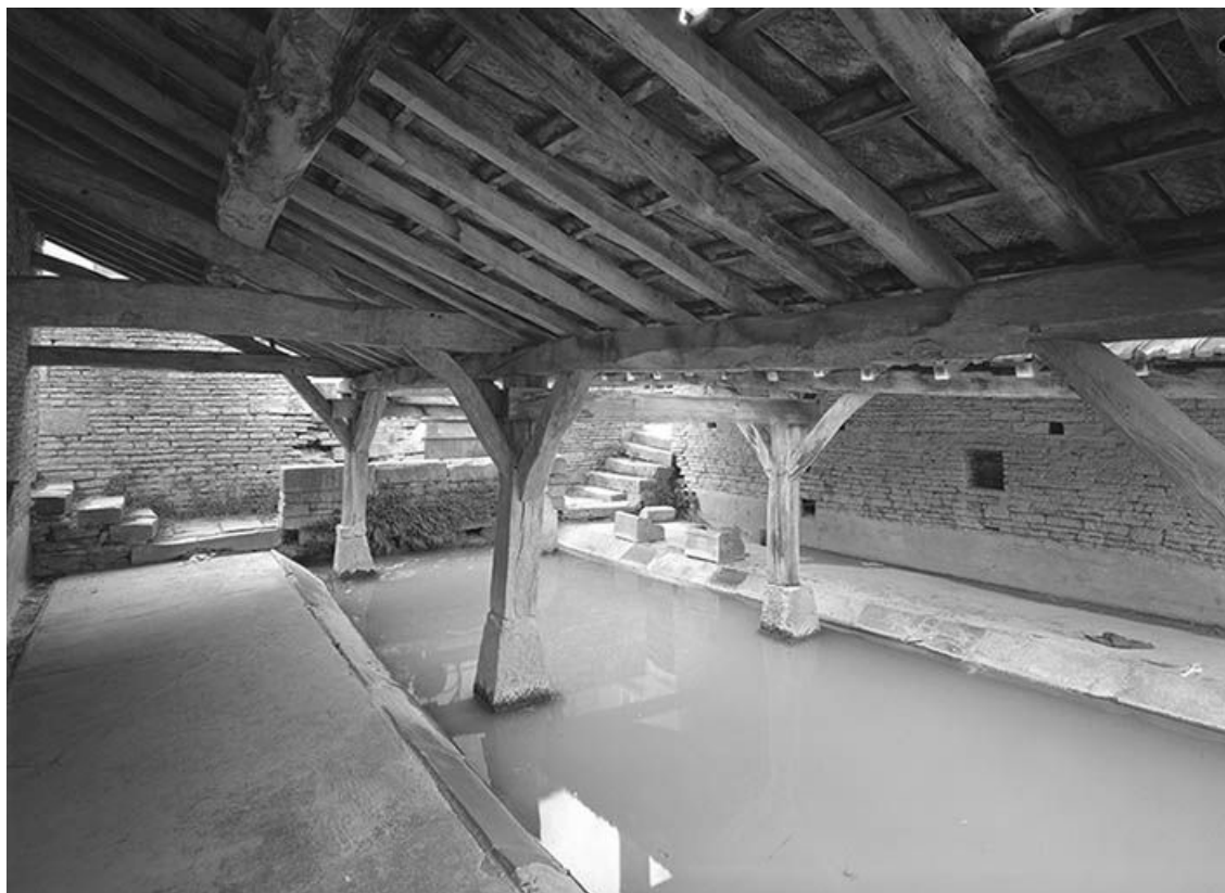
Vue intérieure. Bassin et charpente.
