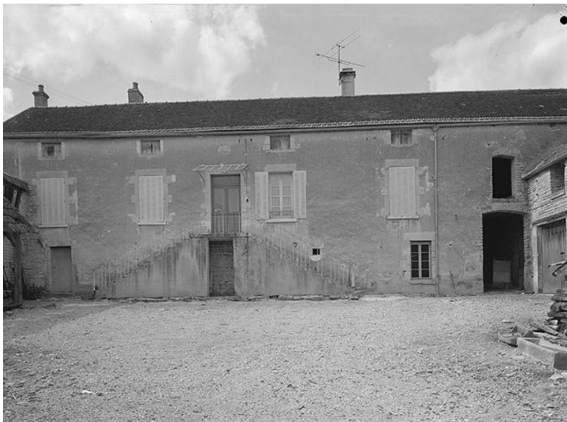
Logis et grange. Façades sur cour.
