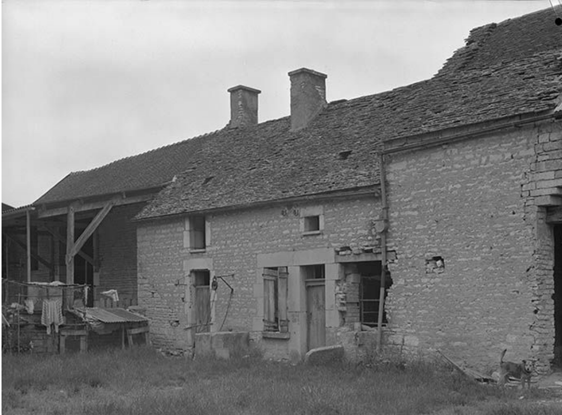
Maison et puits adossé à la façade.
