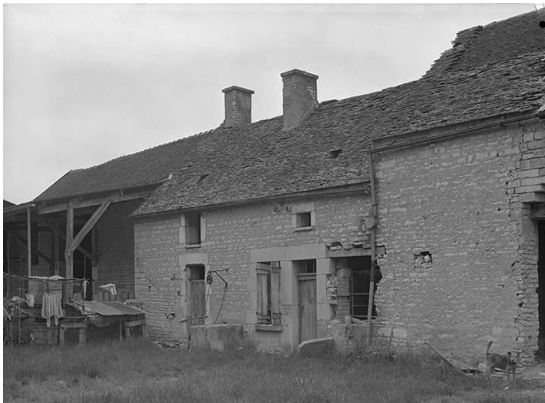
Maison et puits adossé à la façade.
