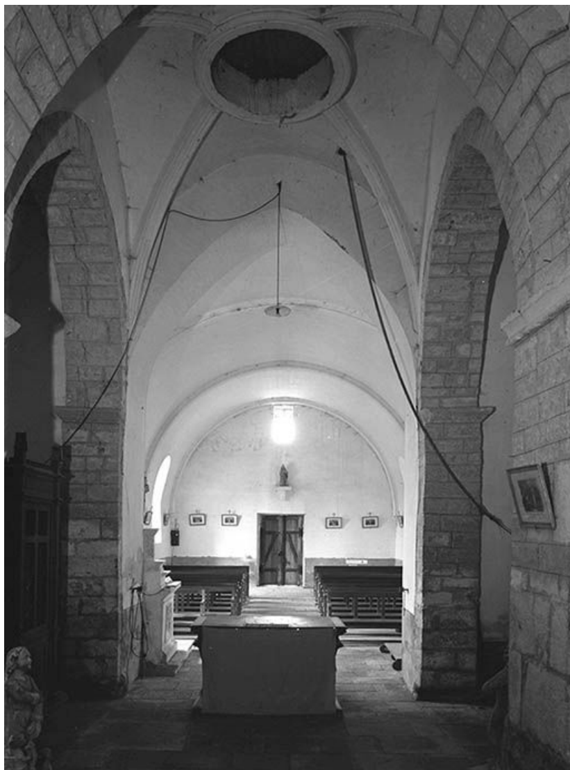
Vue intérieure prise depuis le chœur.
