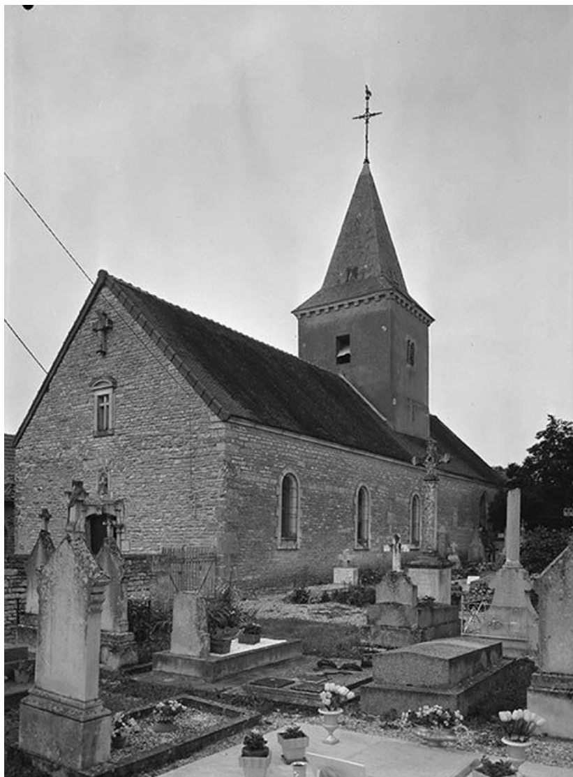
Façade occidentale et bas-côté sud.
