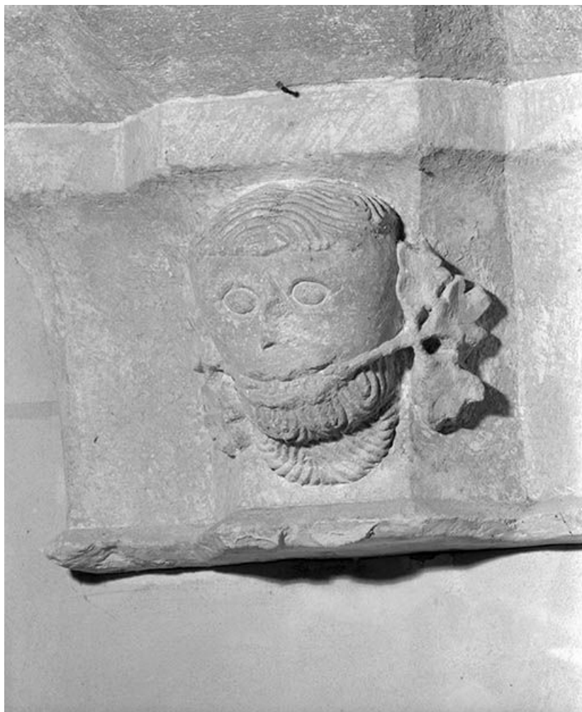
Bas-côté gauche, entre la 1ère et la 2e travée. Culot sculpté d'une tête d'homme grimaçante tenant une branche dans sa bouche. 89, Ravières
