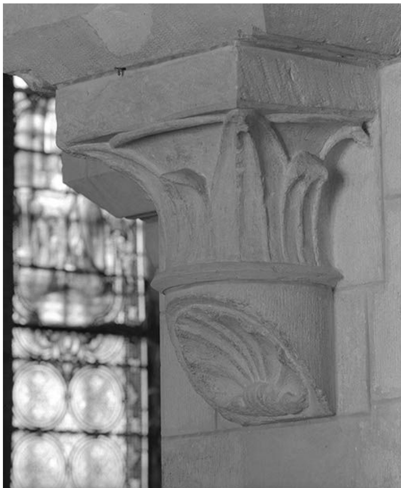
Nef, 2e travée, angle postérieur gauche. Chapiteau-console avec coquille Saint-Jacques sculptée au départ de la colonne. 89, Ravières
