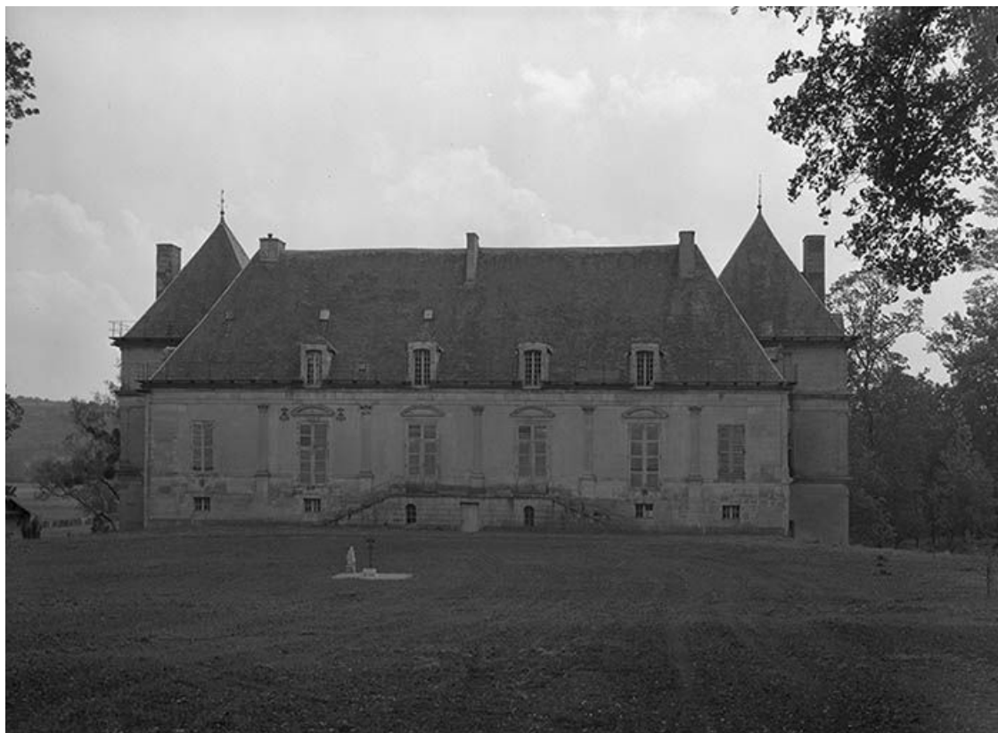
Corps de logis principal flanqué de deux pavillons. Façade principale. 89, Nuits
