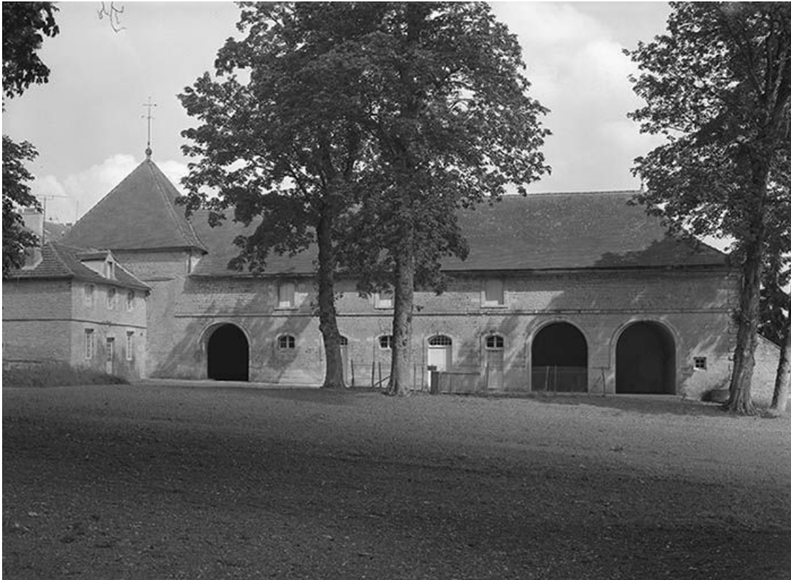
Bâtiment de communs.
