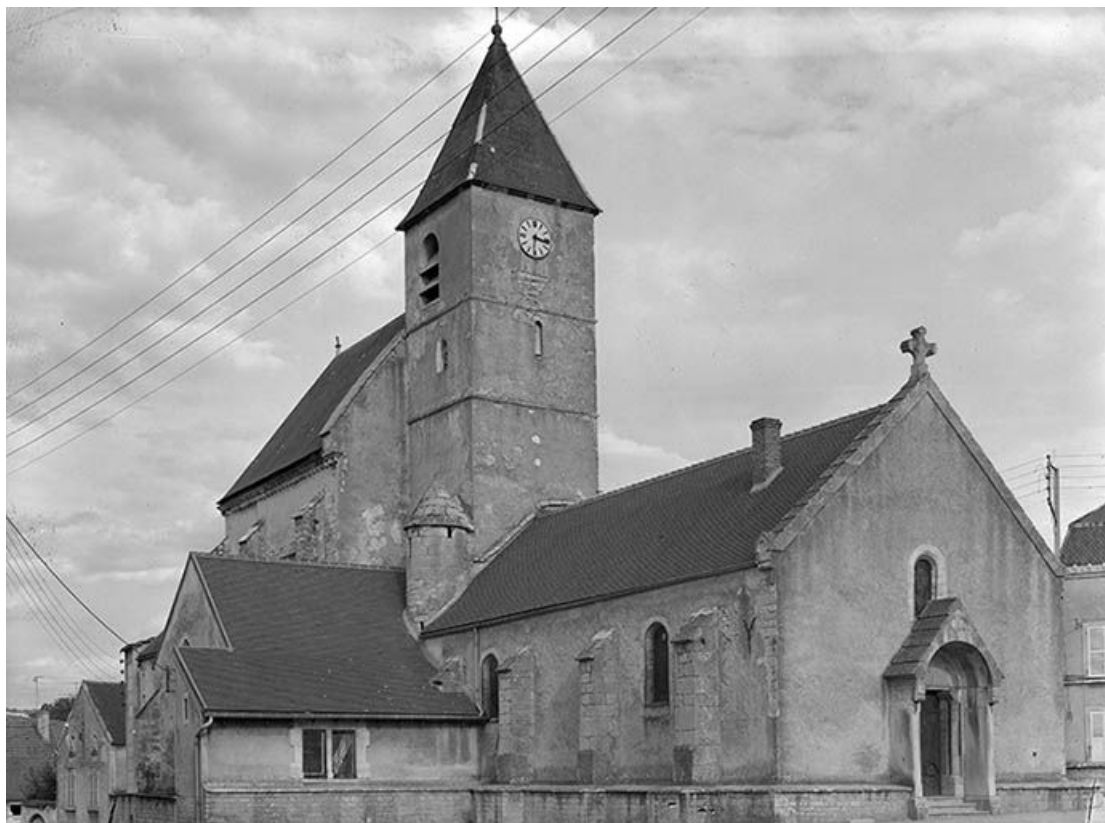
Façade occidentale, bas-côté et transept nord. 89, Nuits
