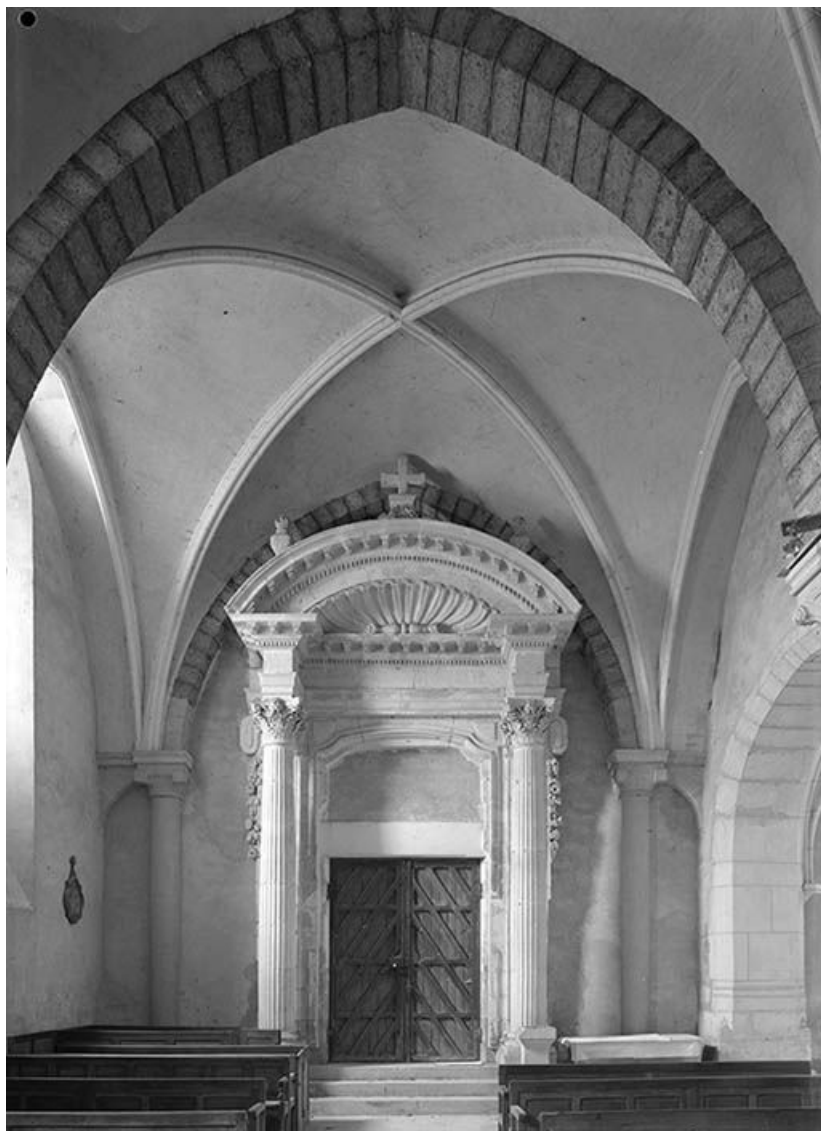
Travée d'un bas-côté avec porte monumentale.
