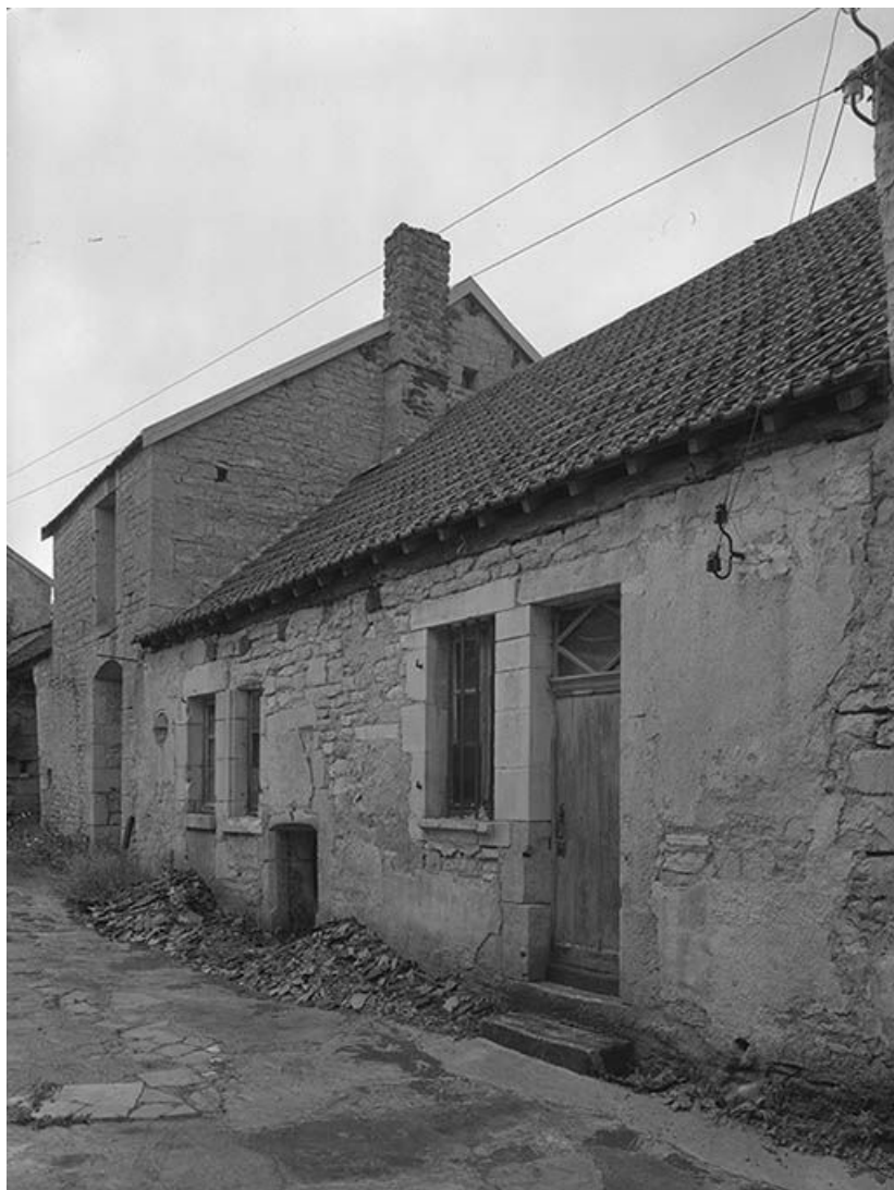
Grange, fenil et maison. Façades sur l'impasse donnant sur la rue du Moulin.
