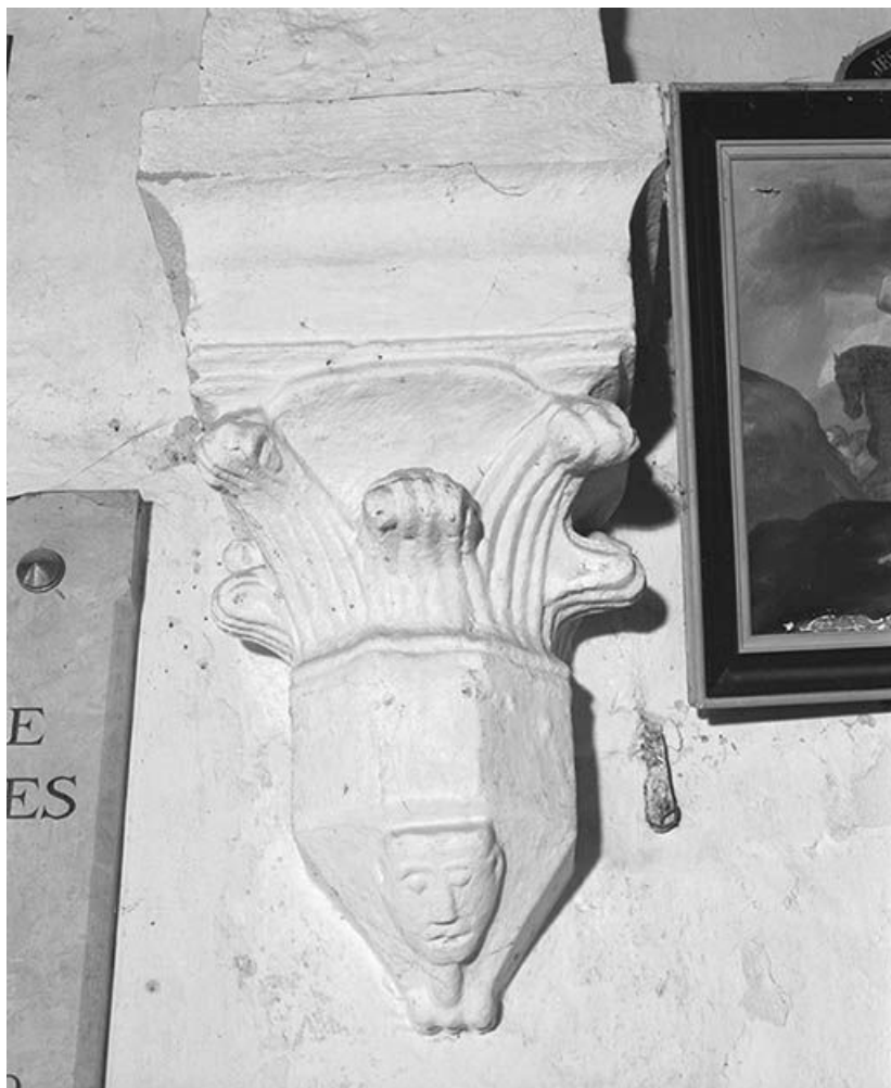
Culot polygonal orné d'une tête humaine fruste supportant un chapeau à crochets nervurés et haut tailloir, sur lequel repose le doubleau de la nef.
