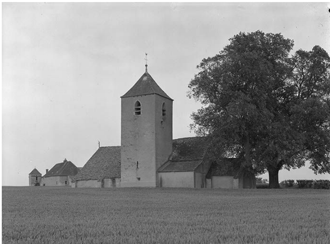
Vue générale côté nord-est (bas-côté et chevet). 89, Chassignelles
