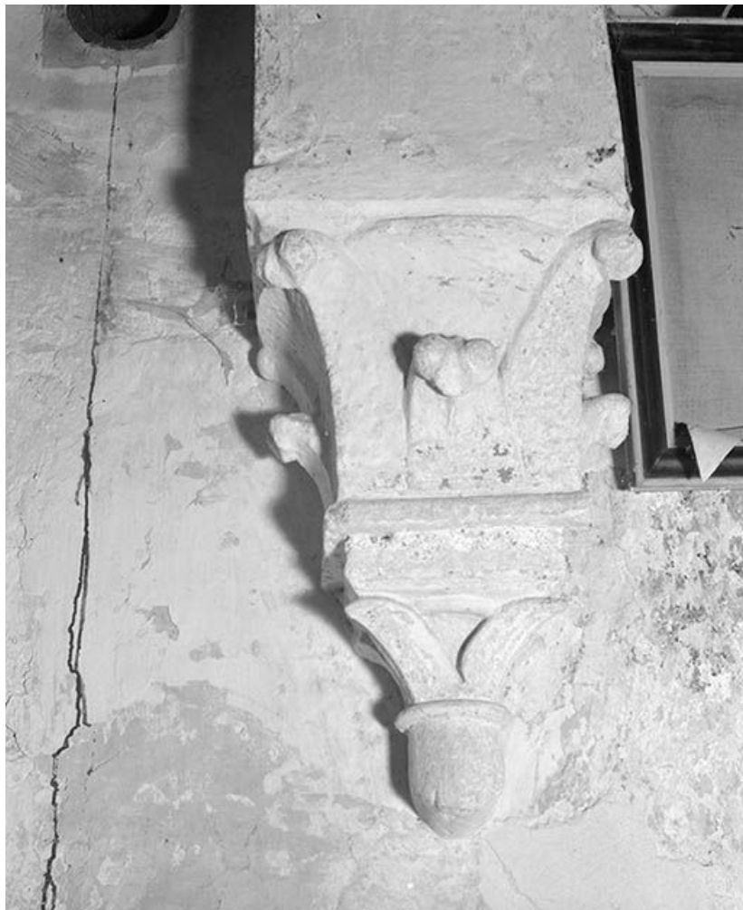
Chapiteau à crochets prolongé par un second chapiteau plus petit, orné de feuilles lisses, sur lequel repose le doubleau du chœur. 89, Chassignelles
