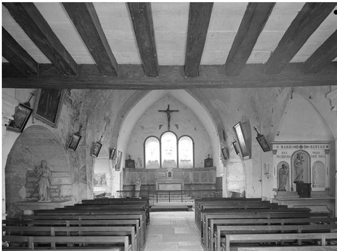
Vue intérieure vers le chœur. Charpente et mobilier.
