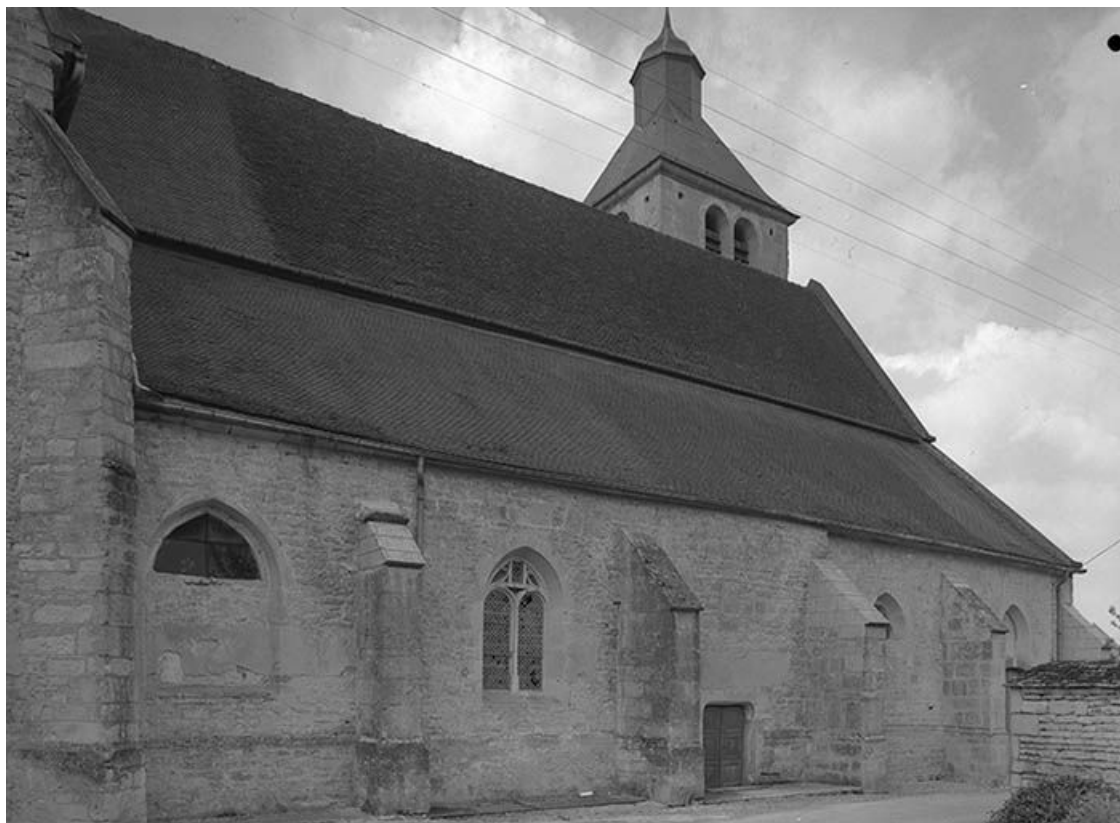
Façade du bas-côté nord.
