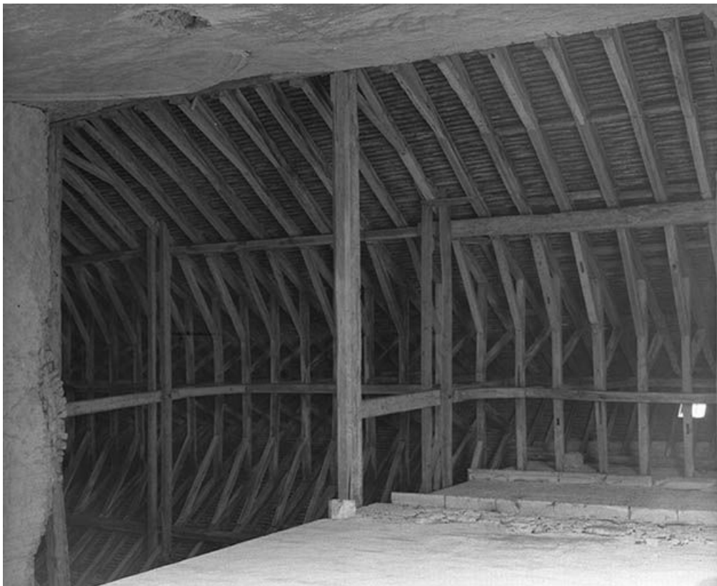
Charpente vue depuis la porte d'entrée du narthex.
