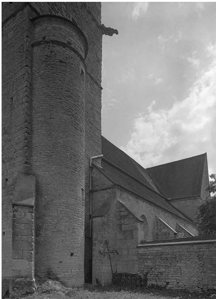
Façade latérale droite et tour d'escalier du clocher.
