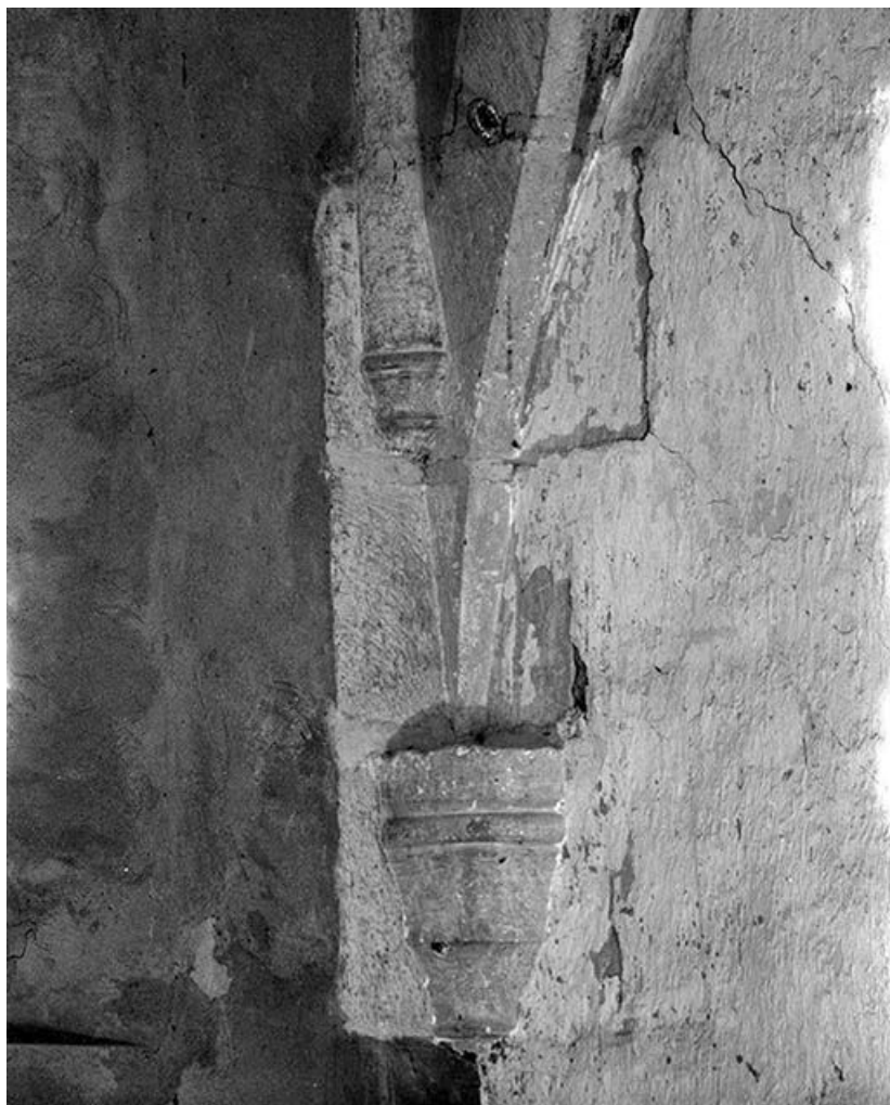
Chapelle latérale droite de l'avant-choeur, détail : supports à l'angle postérieur droit. 89, Argenteuil-sur-Armançon
