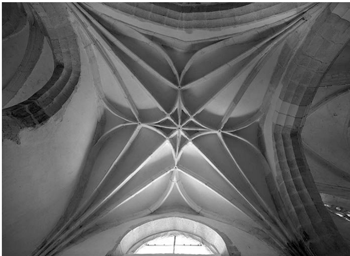
Voûte de la troisième travée du collatéral gauche.
