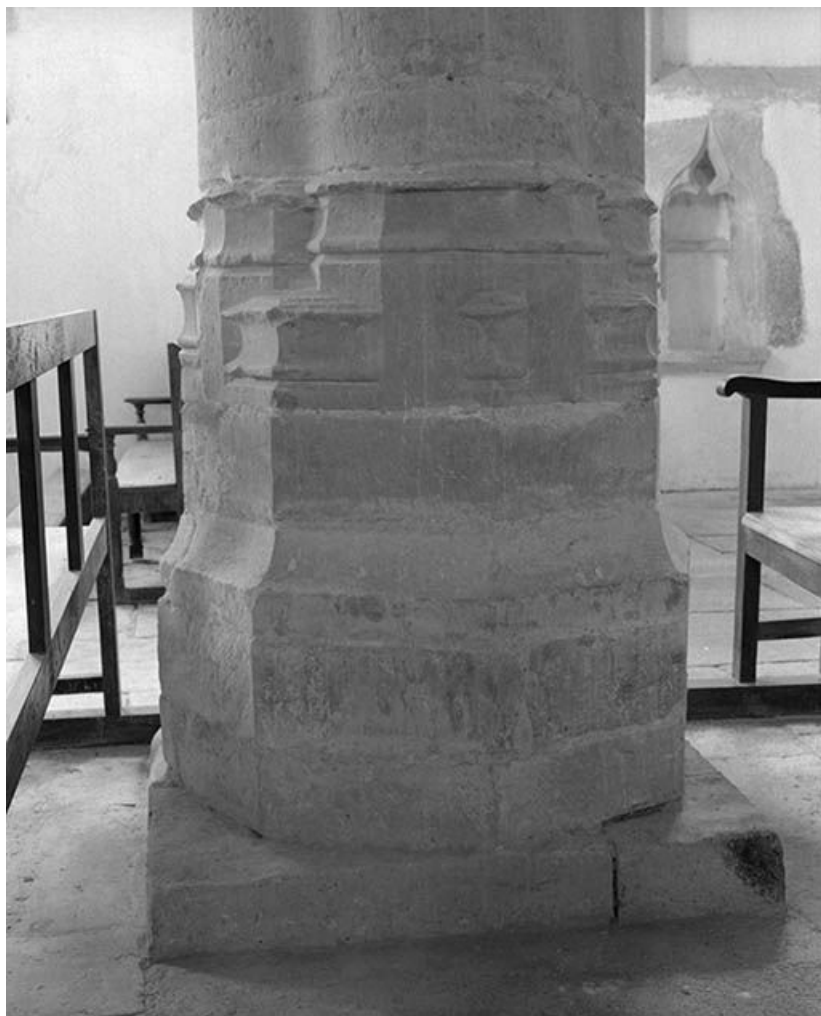
Nef, détail : soubassement du deuxième pilier (à droite).
