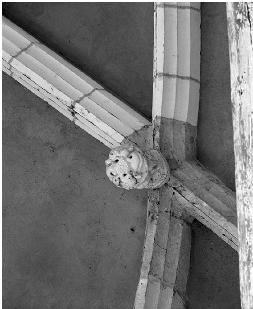
Choeur, détail : clef de voûte. 89, Argenteuil-sur-Armançon
