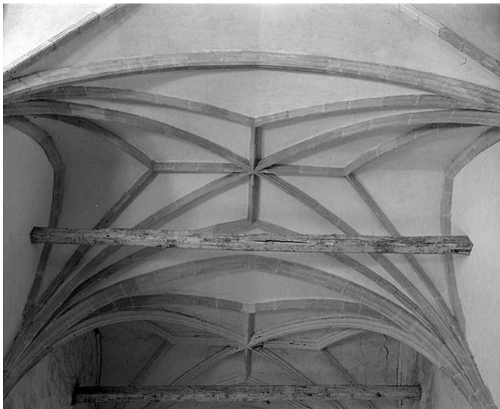
Détail : voûte de la troisième travée de la nef. 89, Argenteuil-sur-Armançon
