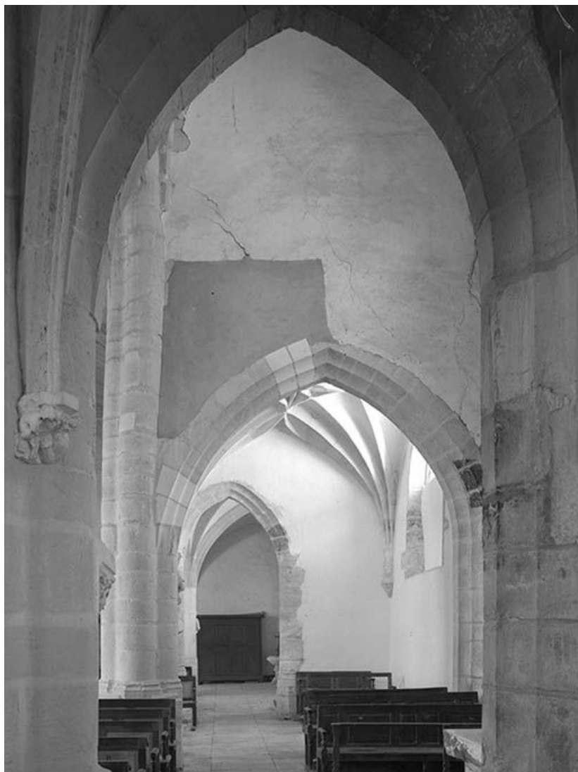
Collatéral gauche, vue depuis le mur postérieur.
