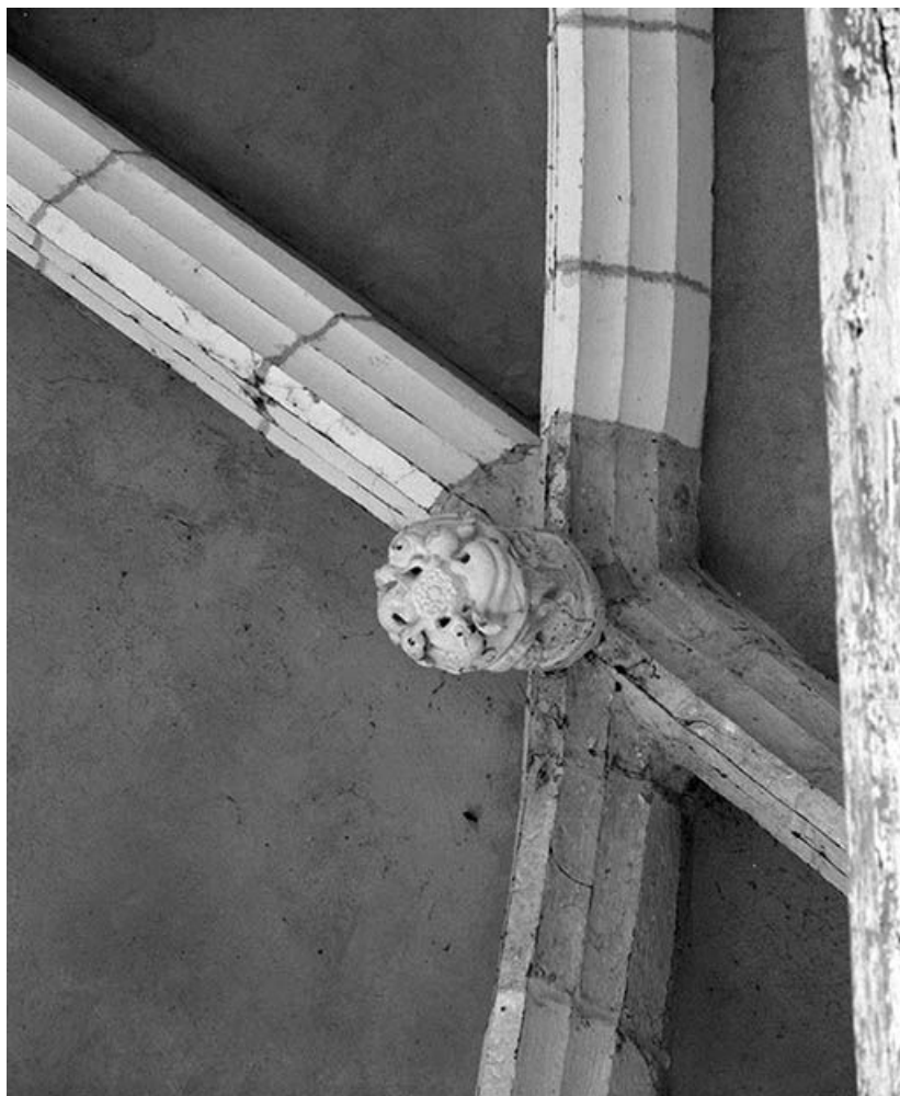
Choeur, détail : clef de voûte. 89, Argenteuil-sur-Armançon
