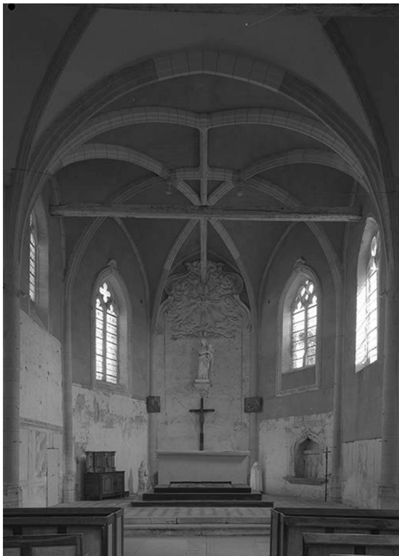
Choeur avec voûte d'ogives. Peinture monumentale.
