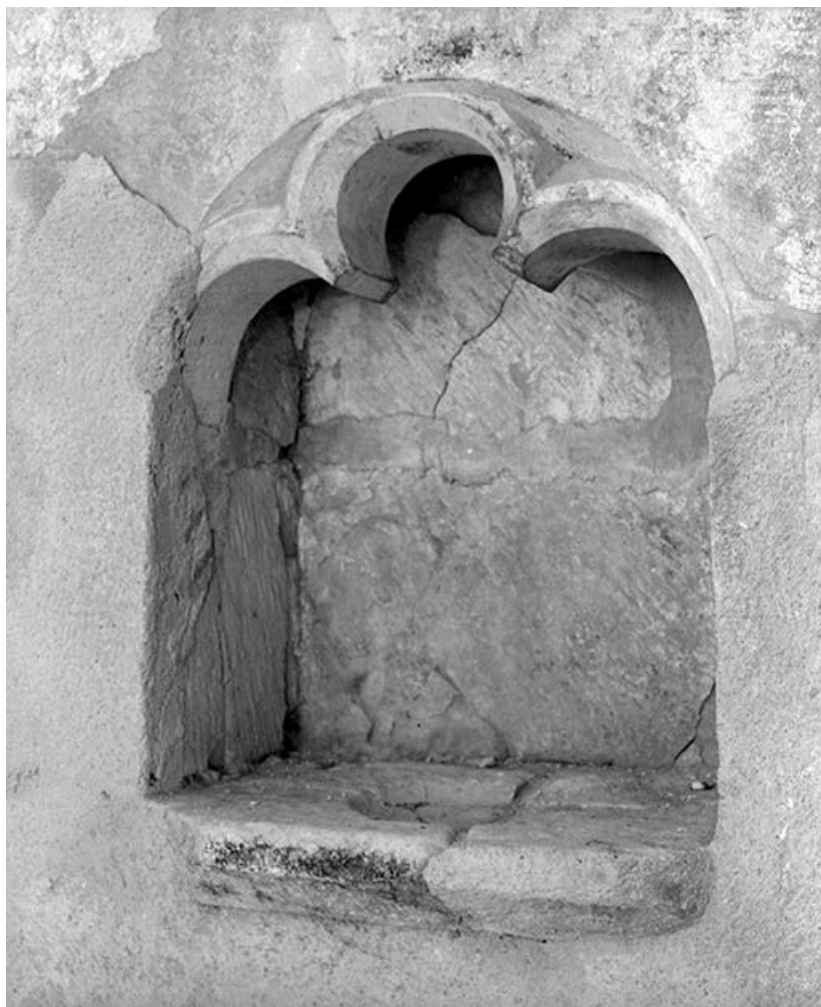
Piscine à arc trilobé, à gauche de la porte d'escalier du chœur. 89, Argenteuil-sur-Armançon
