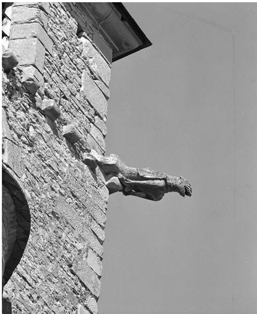
Façade droite du chœur, détail : gargouille droite.
