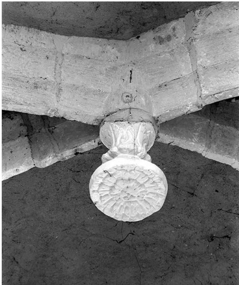
Chapelle latérale gauche de l'avant-choeur, détail : clef de voûte. 89, Argenteuil-sur-Armançon
