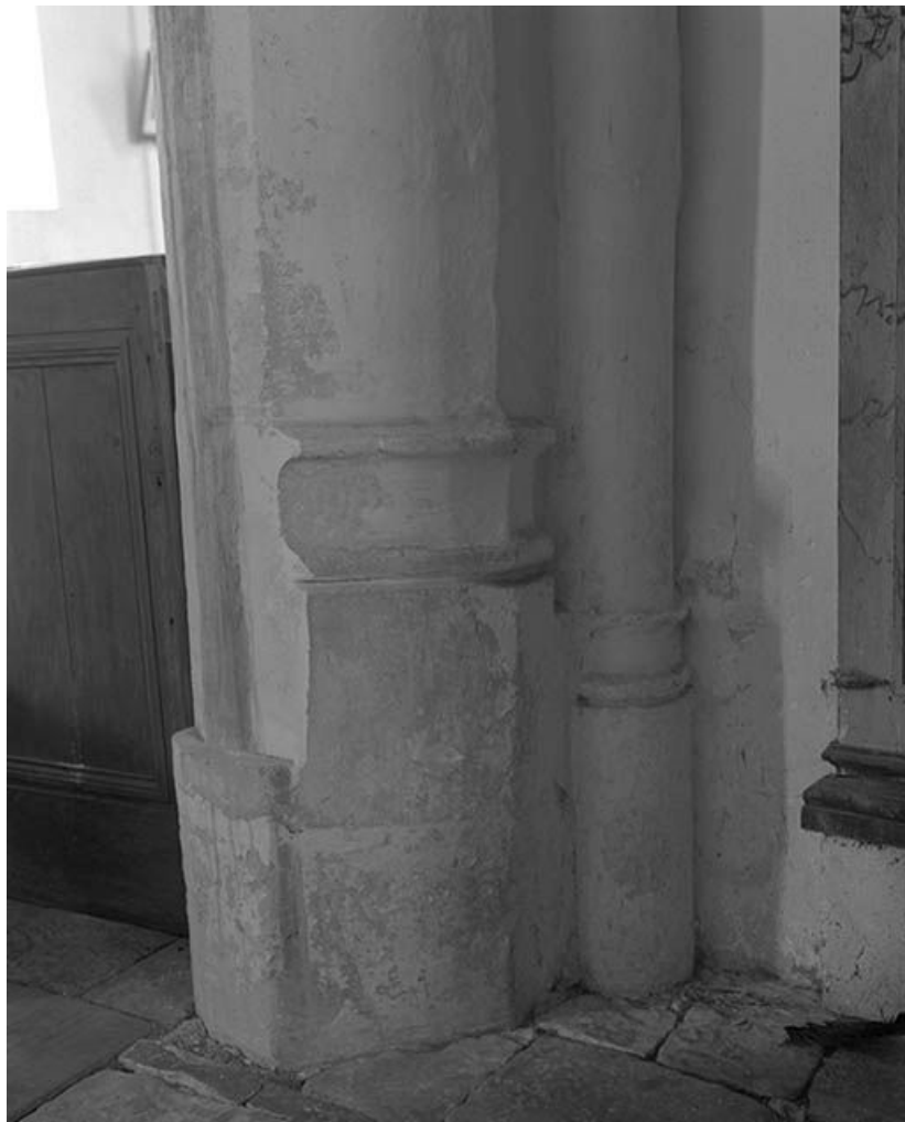
Détail : piédroit de l'arcade donnant accès à la chapelle latérale gauche. 89, Argentenay Grande-Rue
