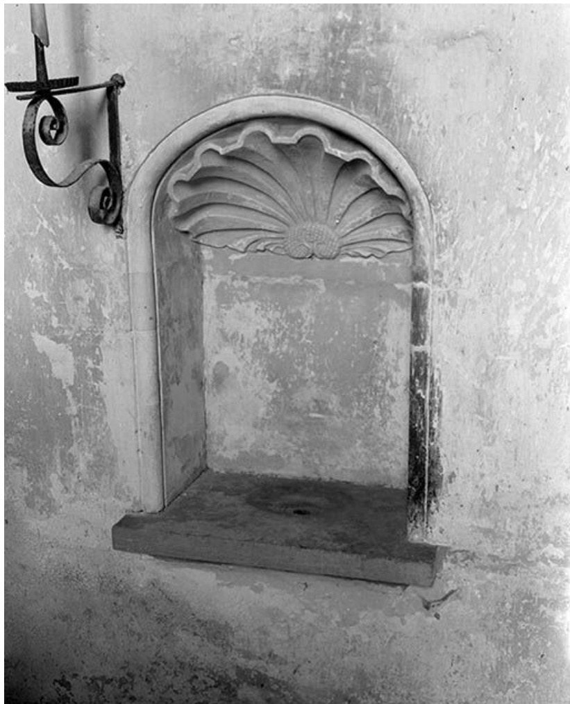
Lavabo dans le mur droit du chœur.
