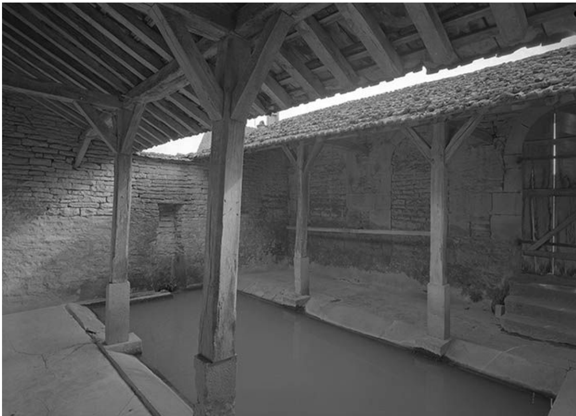
Vue intérieure. Bassin et charpente.
