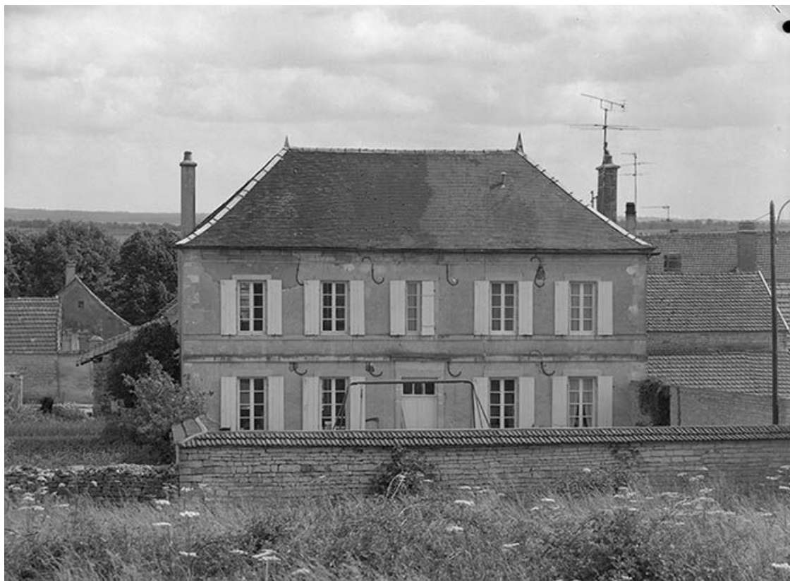
Façade sur cour.
