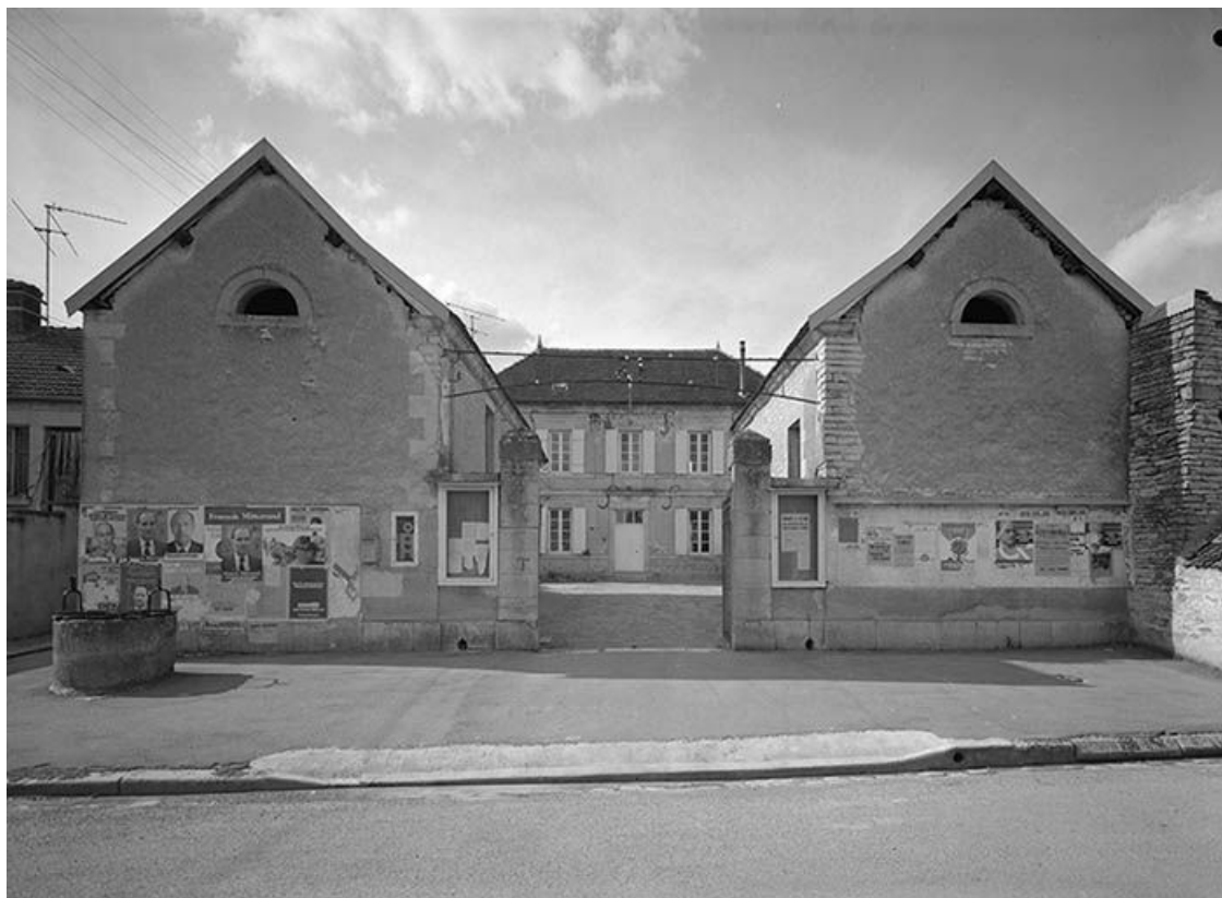
Corps de bâtiment principal (au fond) et bâtiments perpendiculaires indépendants (au 1er plan). 89, Villiers-les-Hauts rue Basse
