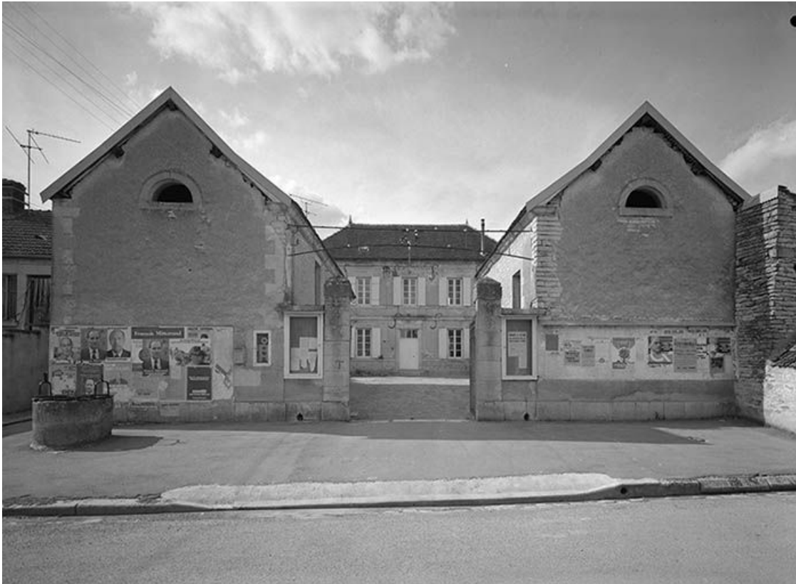
Corps de bâtiment principal (au fond) et bâtiments perpendiculaires indépendants (au 1er plan). 89, Villiers-les-Hauts rue Basse
