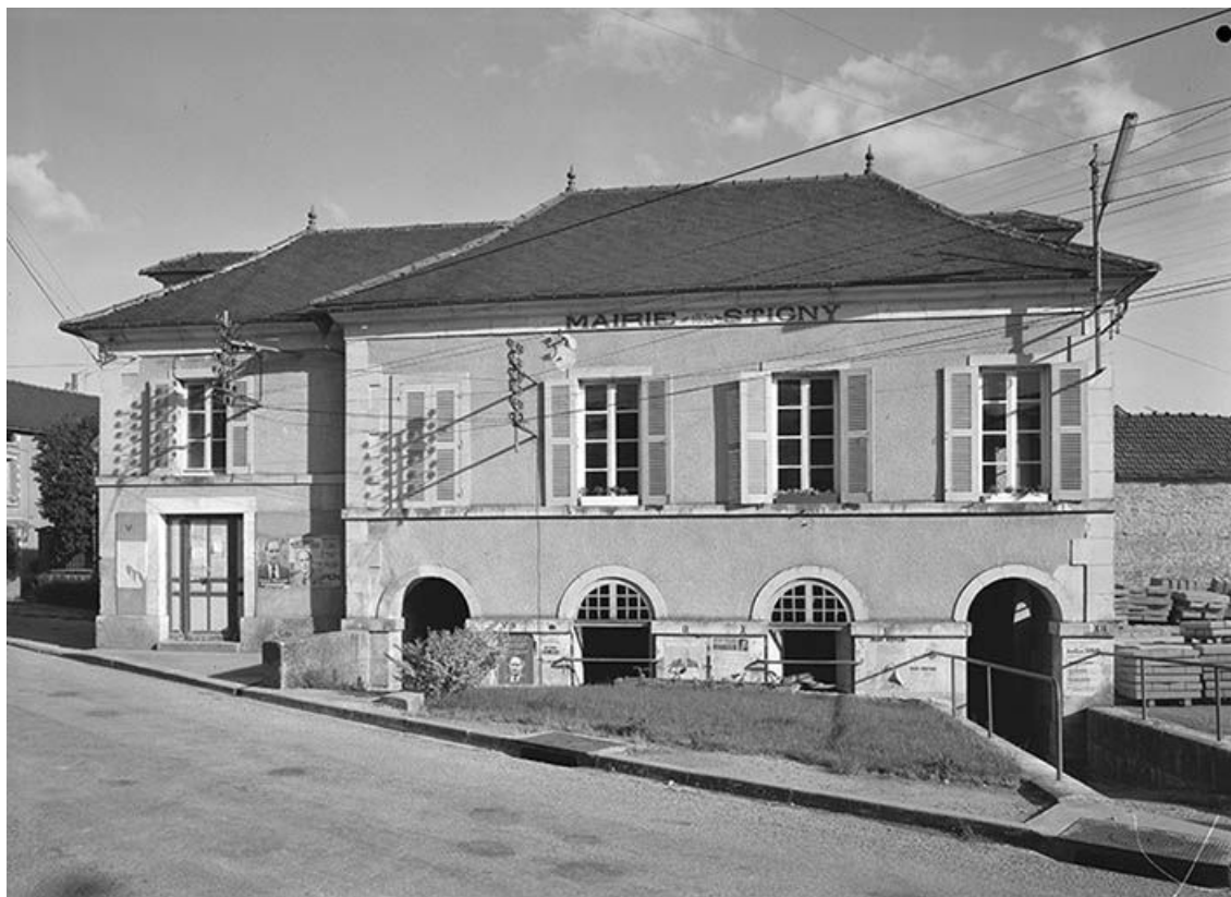
Façade principale avec lavoir en rez-de-chaussée.
