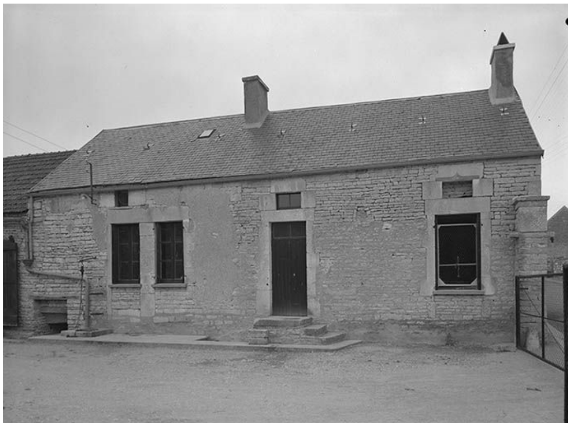
Logis et puits contre le mur. Façade sur cour.
