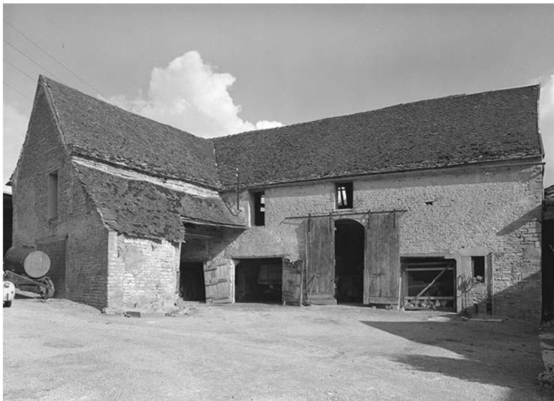
Bâtiments d'exploitation. Façades sur cour.
