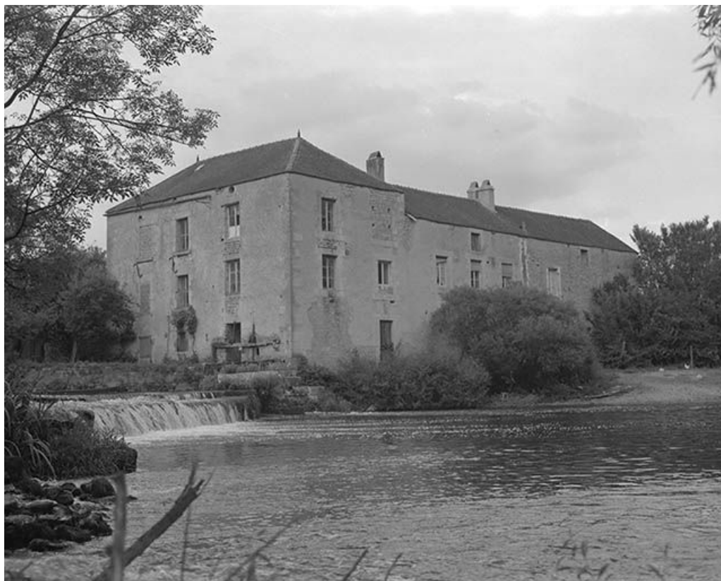
Moulin alimenté par un bief de l'Armançon. Vue extérieure.
