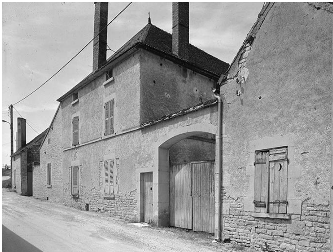
Façade sur rue avec porte piétonne et porte charretière.
