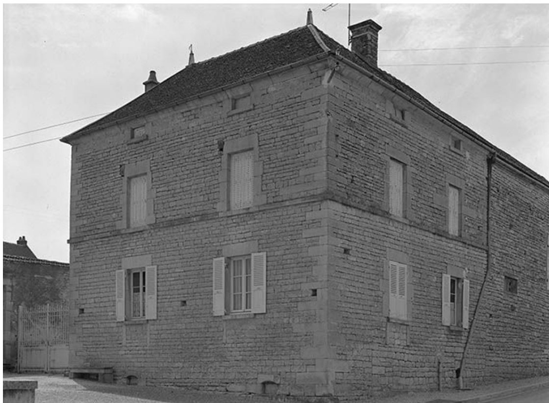
Façades sur la rue et sur la place.
