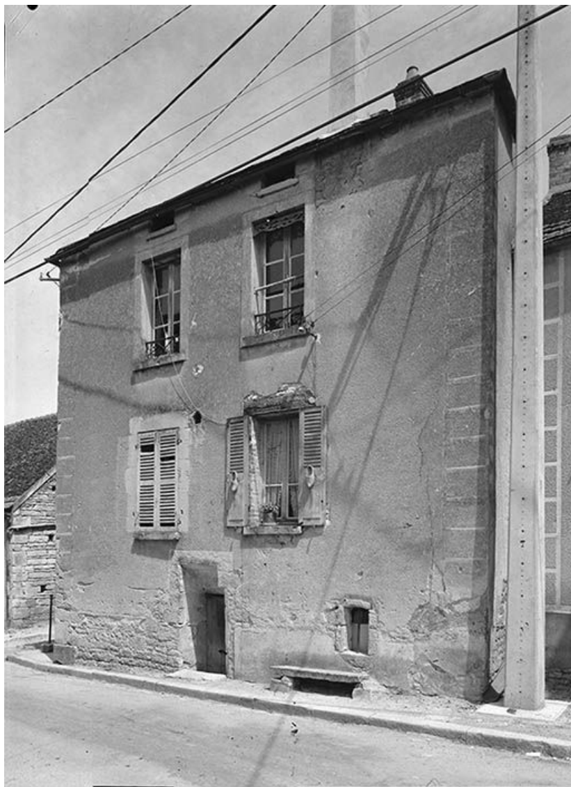
Façade antérieure sur rue.
