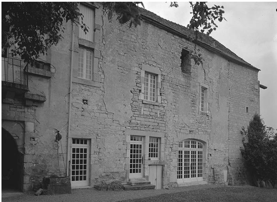
Façade sur cour.
