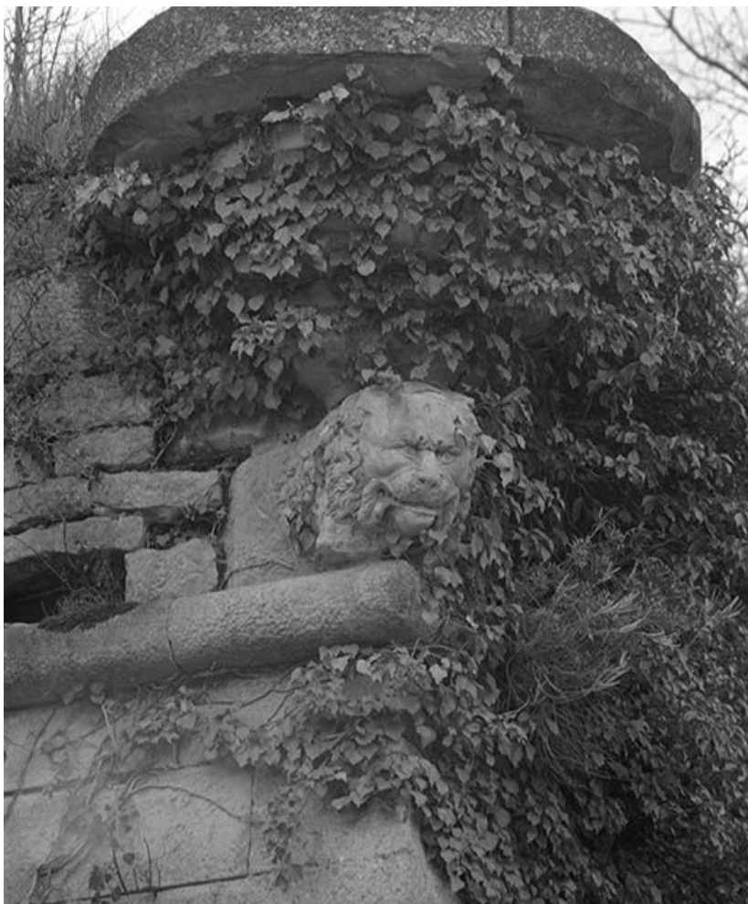
Tête de lion sculptée sous le cul-de-lampe d'une des tourelles en surplomb du mur de soutènement de la terrasse. 89, Pacy-sur-Armançon C.D. 118
