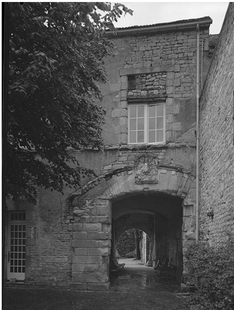
Passage voûté reliant l'un des bâtiments du château aux bâtiments de la mairie-école. 89, Pacy-sur-Armançon C.D. 118
