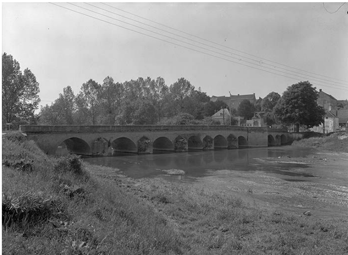
Pont sur l'Armançon (pont routier).
