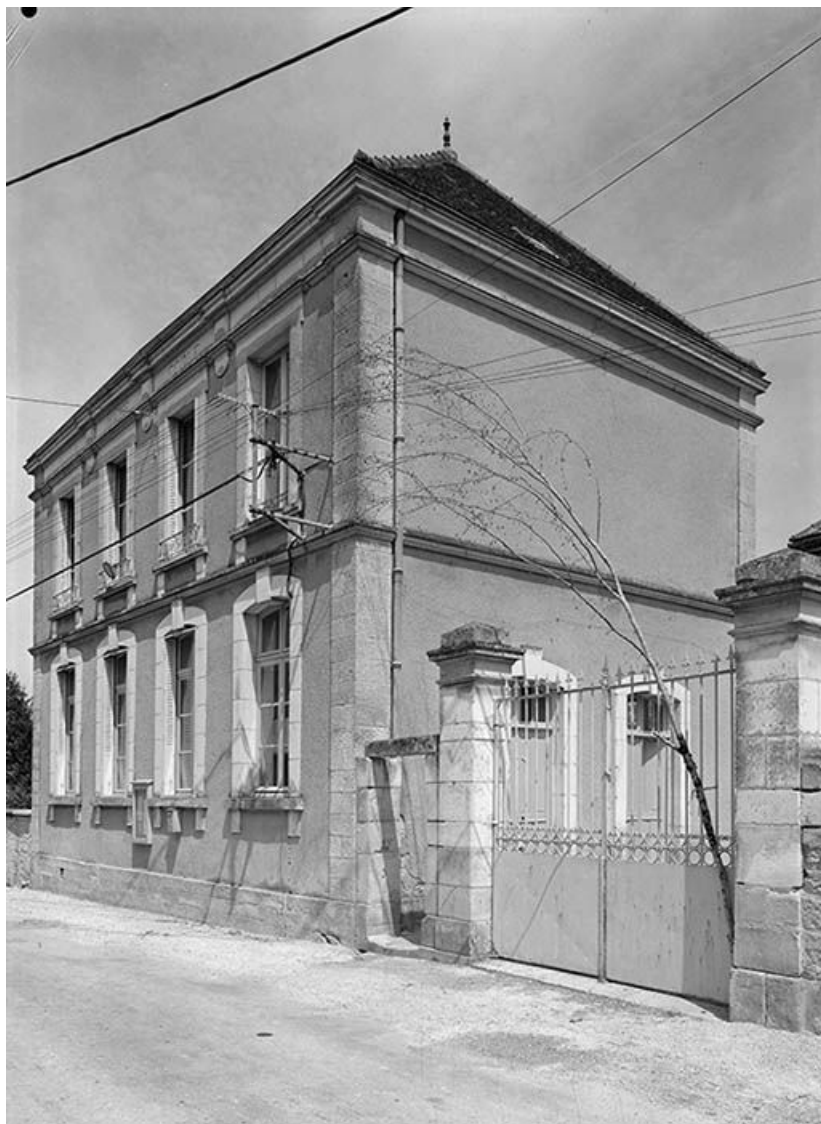
Façade antérieure sur rue et portail.
