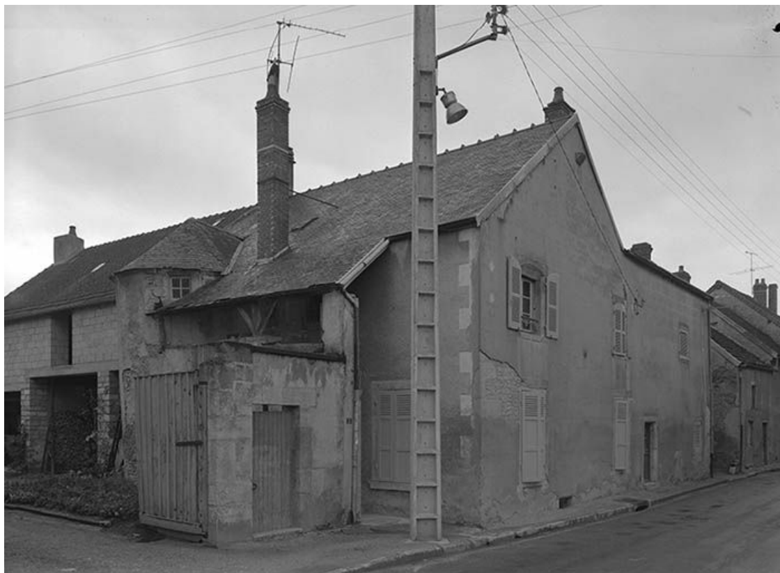
Façade antérieure flanquée d'une tourelle demi-hors-oeuvre (à gauche) et mur-pignon sur rue. 89, Nuits R.N. 5
