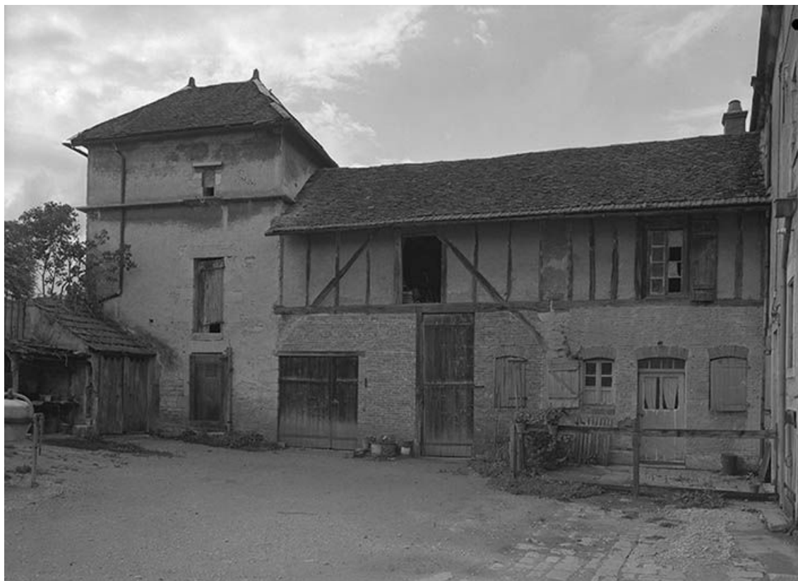
Bâtiment abritant la grange (au rez-de-chaussée), le fenil (à l'étage) et une habitation (à droite). Façade sur cour. 89, Nuits R.N. 5
