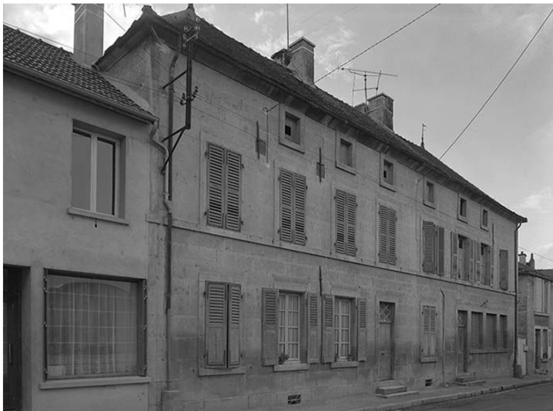
Logis d'habitation. Façade sur route. 89, Nuits R.N. 5
