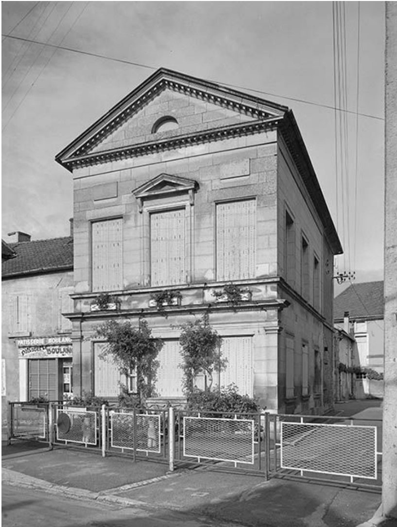
Mur-pignon sur rue.
