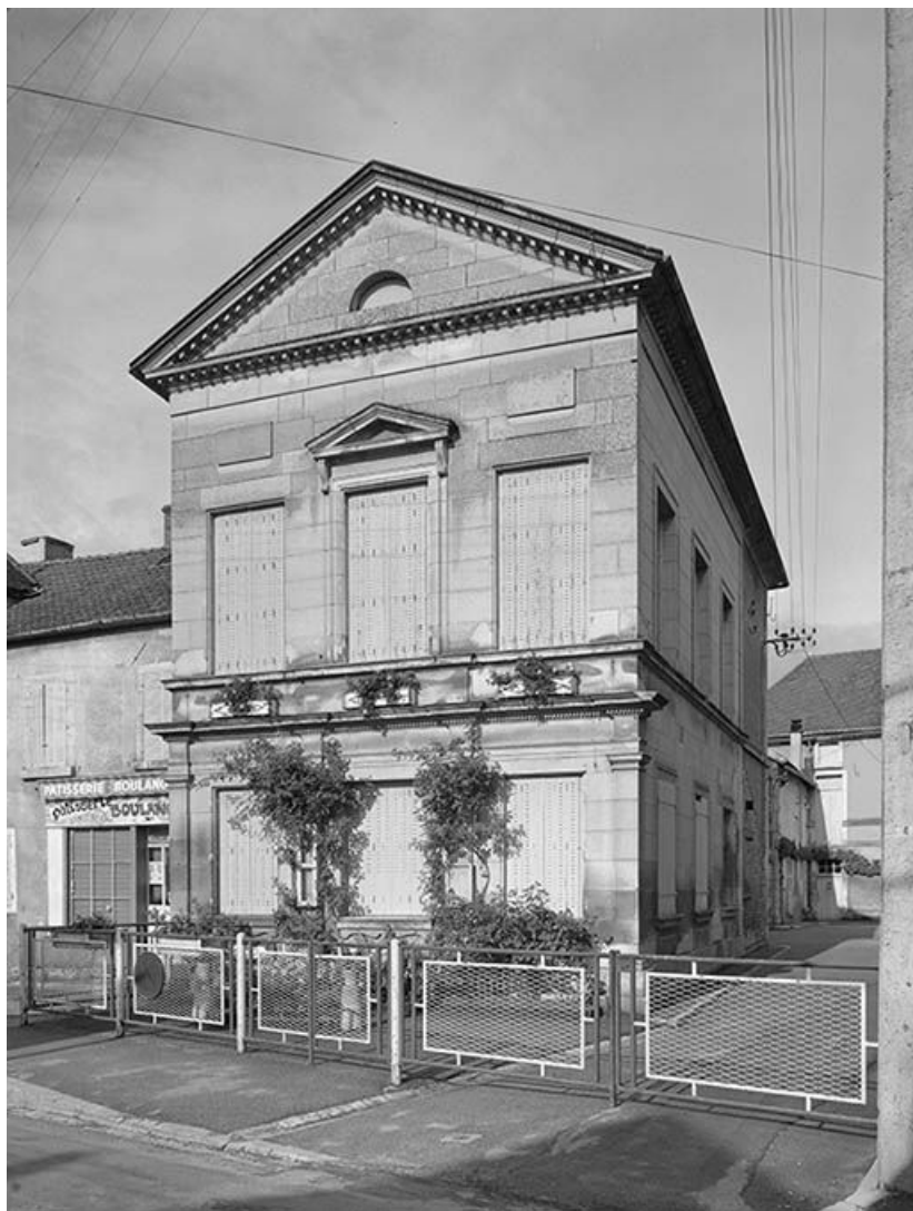
Mur-pignon sur rue.
