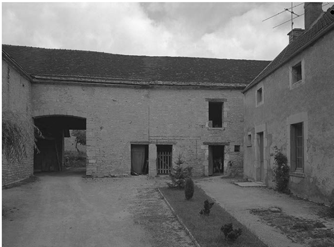
Dépendances et logis d'habitation (à droite). Façades sur cour.
