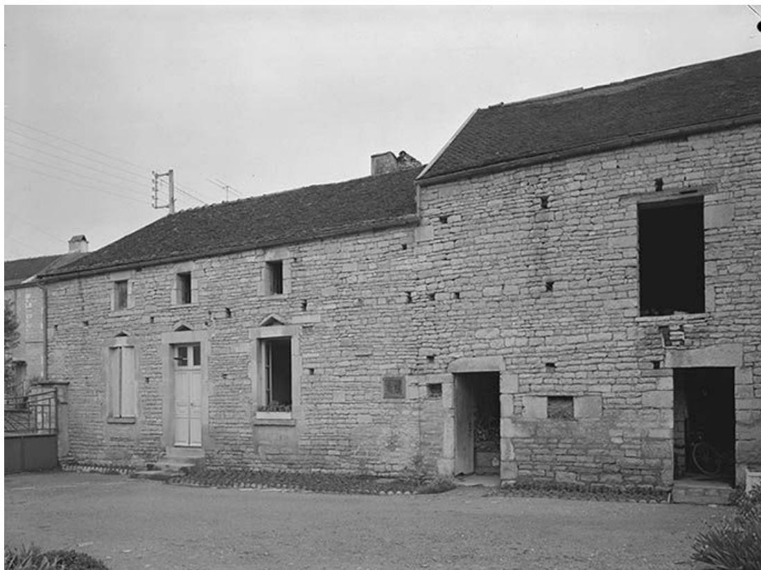
Logis d'habitation et corps de dépendances (étable et fenil). Façades sur cour. 89, Lézennes Grande-Rue
