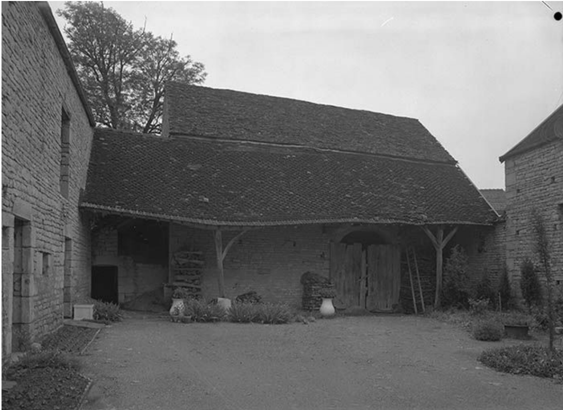
Grange. Façade sur cour. 89, Lézennes Grande-Rue
