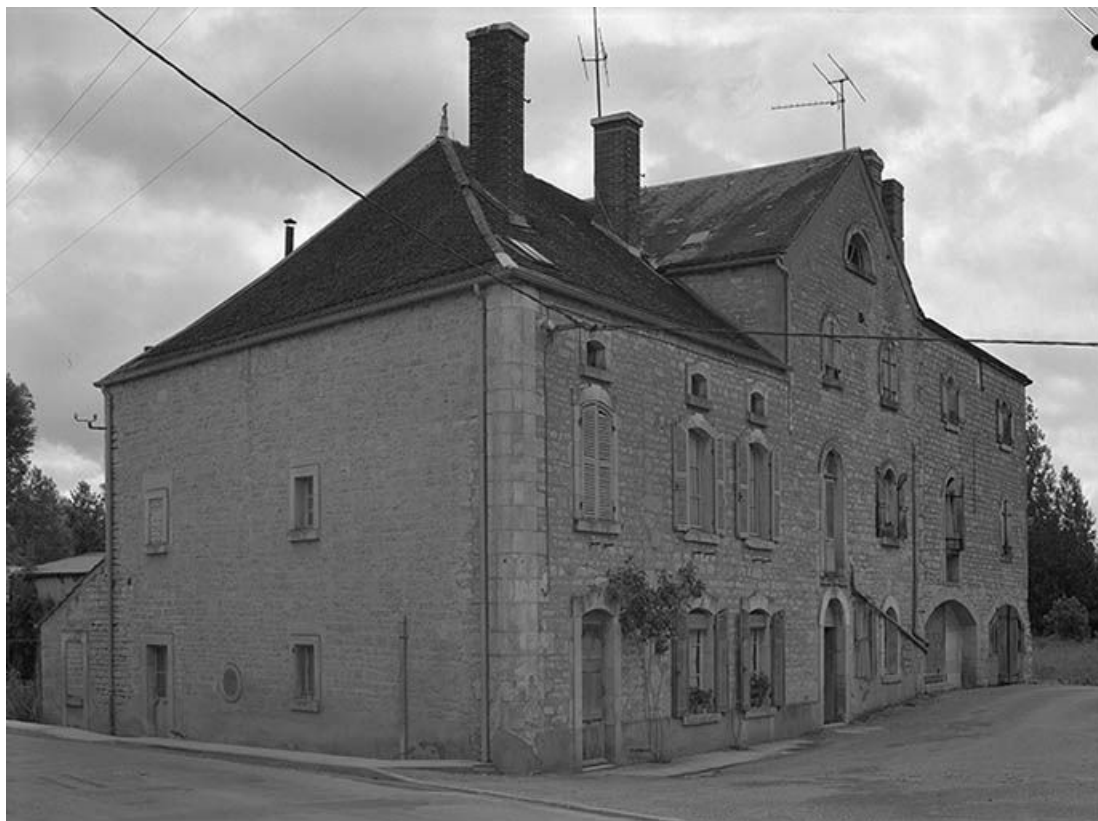
Façades principales des trois corps de bâtiments constituant l'ancien moulin. 89, Lézennes chemin de Ronde
