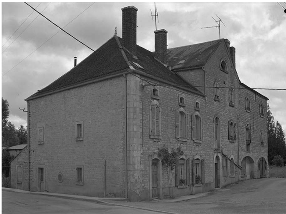
Façades principales des trois corps de bâtiments constituant l'ancien moulin. 89, Lézennes chemin de Ronde
