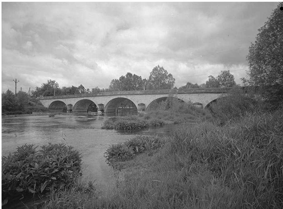
Pont sur l'Armançon (pont routier).
