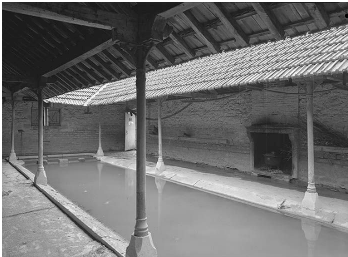
Vue intérieure. Bassin central, charpente et cheminée.
