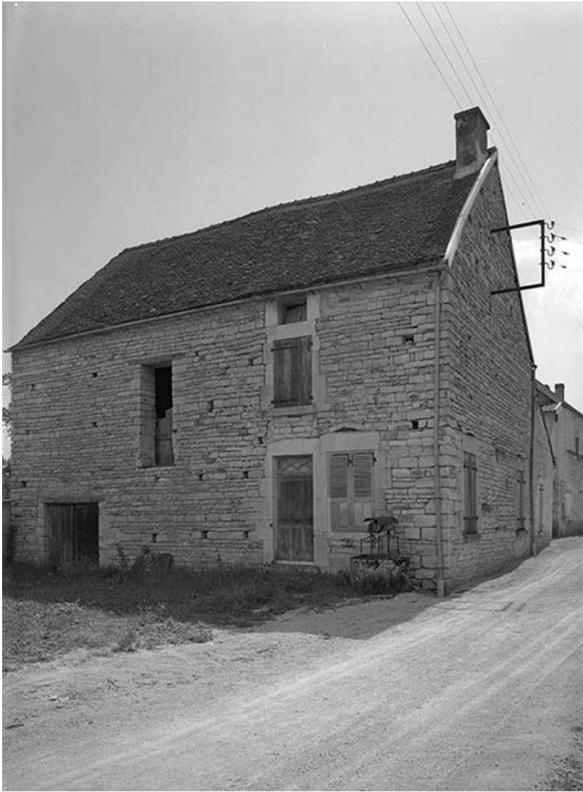
Façade antérieure et mur-pignon sur rue.
