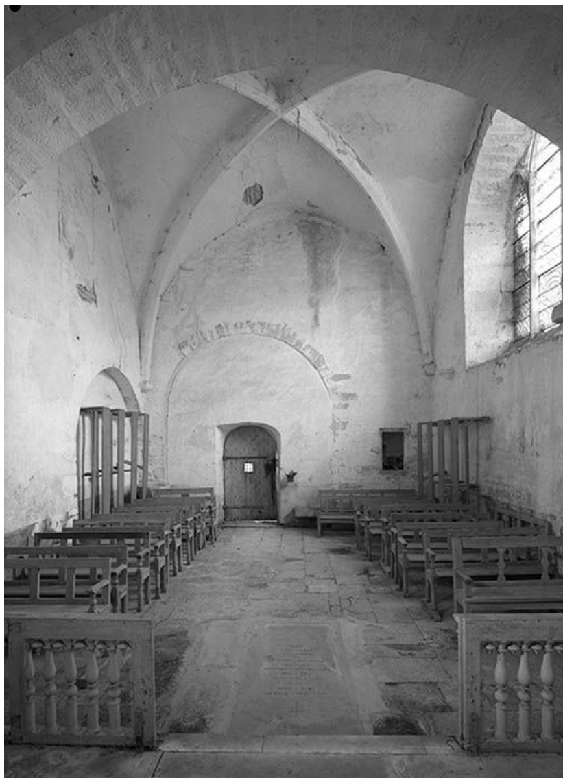
Nef, vue depuis le chœur. 89, Pacy-sur-Armançon
