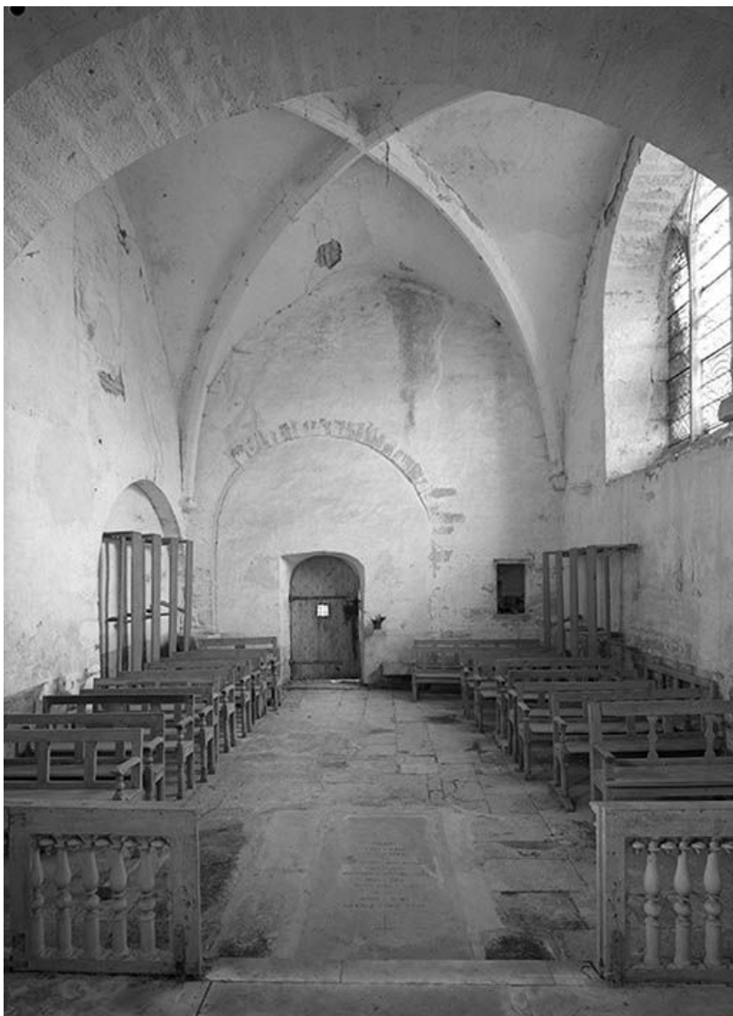
Nef, vue depuis le chœur. 89, Pacy-sur-Armançon
