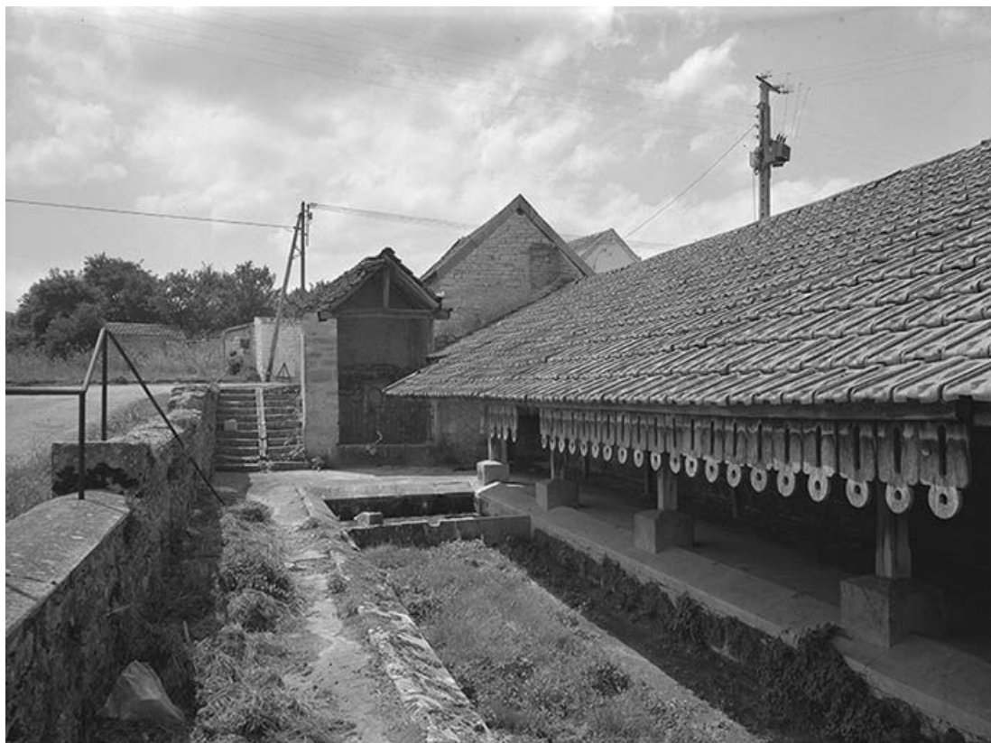
Vue extérieure, avec bassin et décoration en bois découpé sur la bordure du toit.
