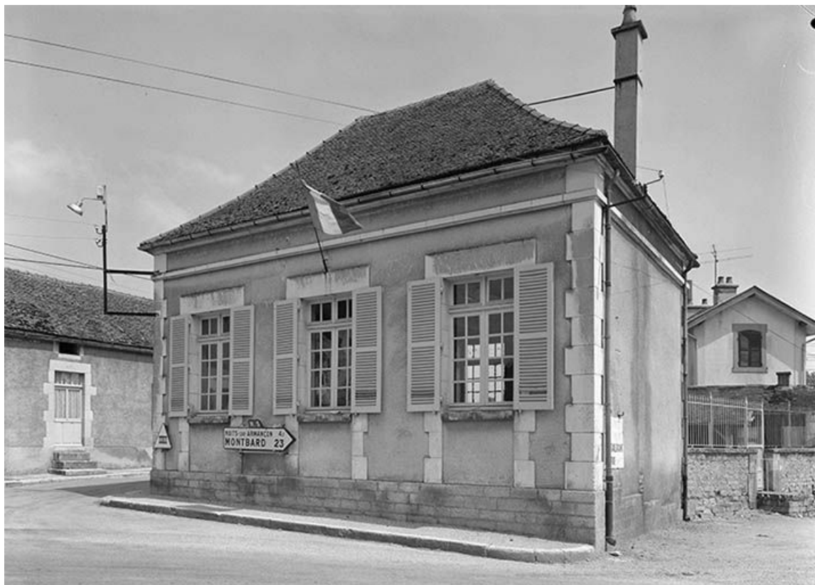
Façade postérieure et façade latérale gauche (aveugle).
