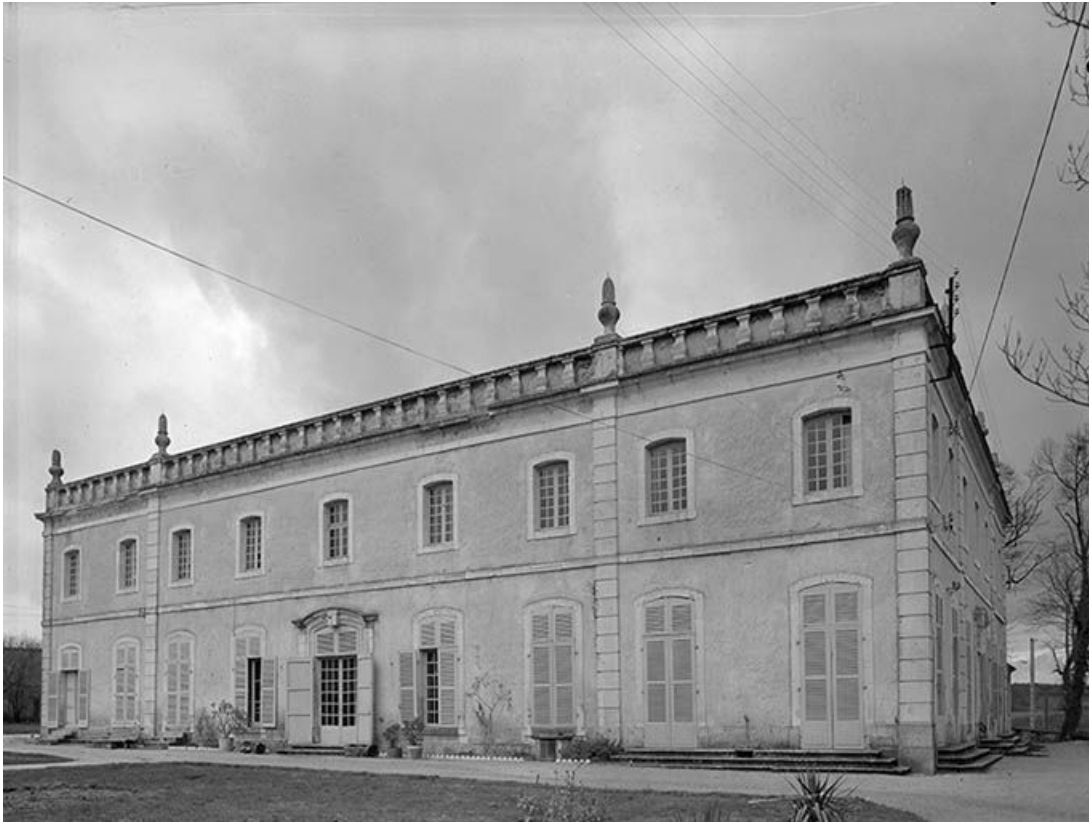
L'un des deux corps de bâtiments principaux. Façade antérieure. 89, Fulvy C.D. 12
