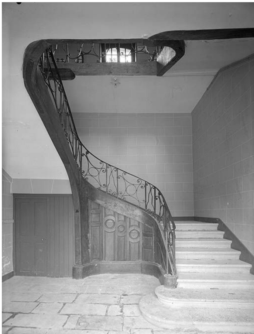
Escalier intérieur (au centre du corps de façade). 89, Fulvy C.D. 12
