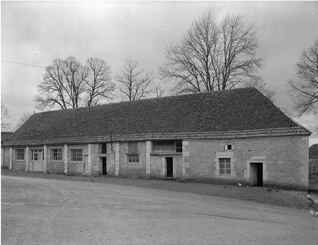
Corps de bâtiment secondaire. Façade sur cour. 89, Fulvy C.D. 12
