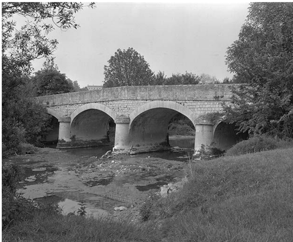
Pont sur un bras de l'Armançon (pont routier). 89, Fulvy C.V. 1
