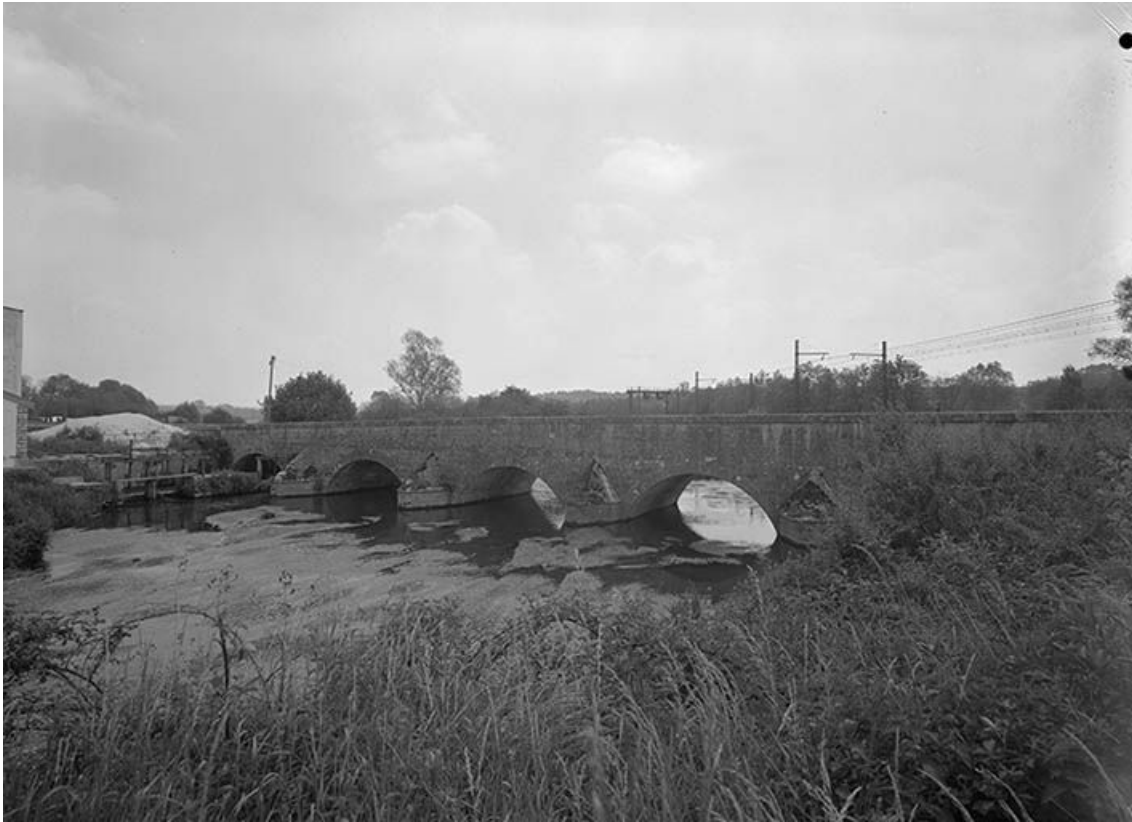
Pont sur l'Armançon (pont routier).
