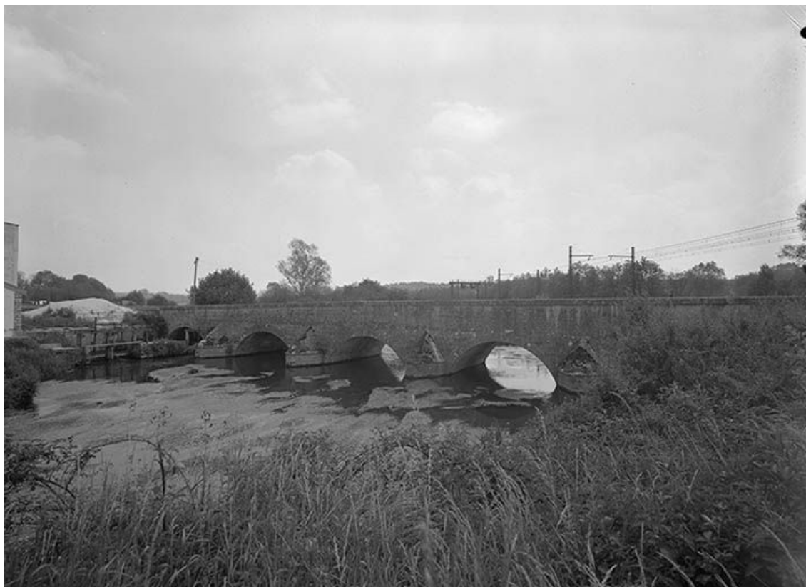
Pont sur l'Armançon (pont routier).
