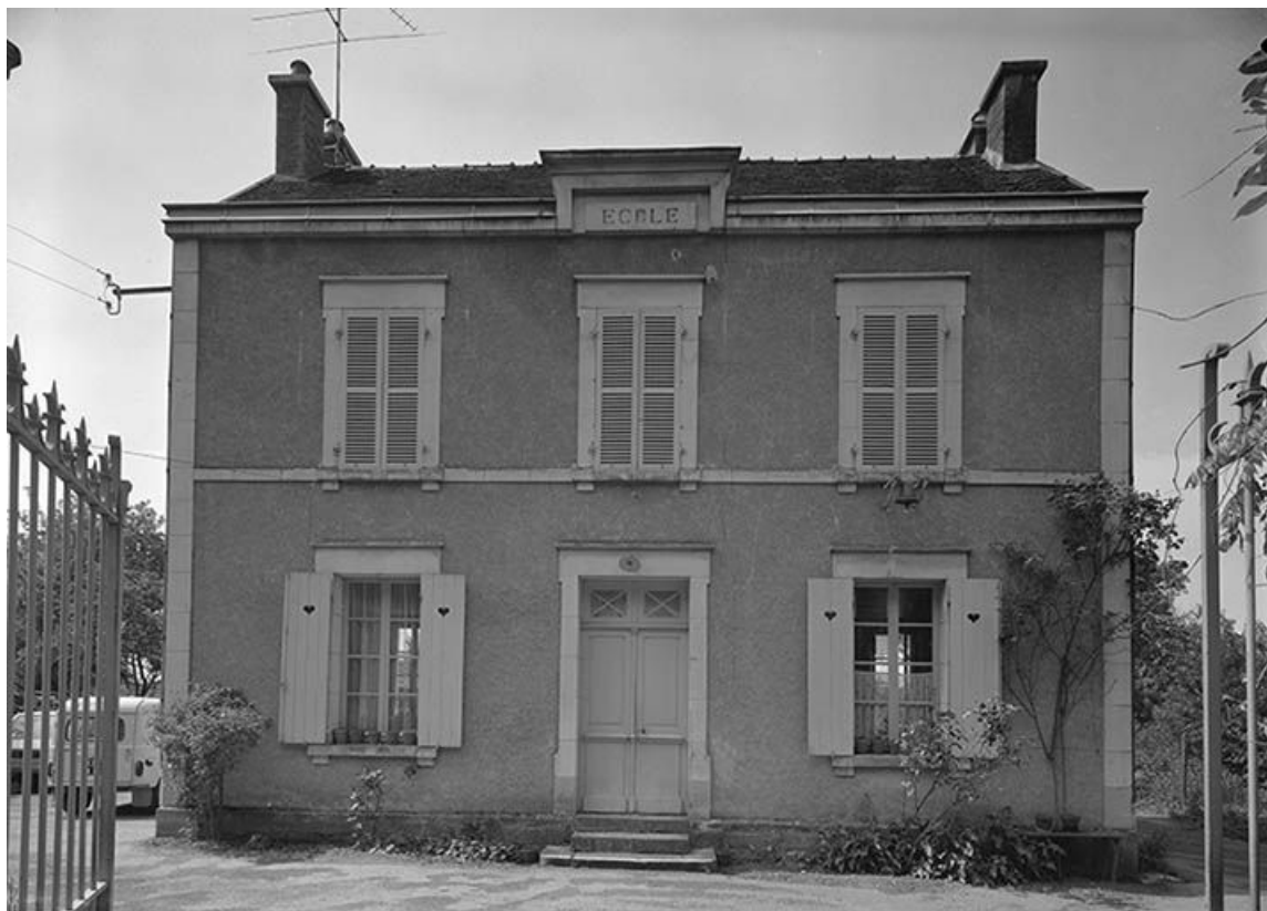
Ecole sise parcelle AC 28, du cadastre de 1963 : façade.
