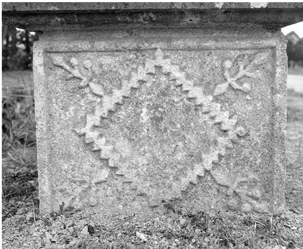
Croix de chemin. Ornement géométrique sur le soubassement.
