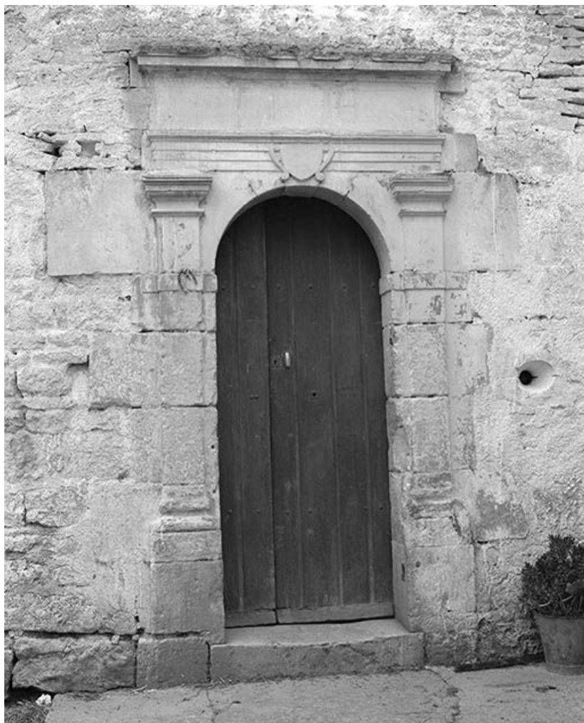
Porte d'entrée de la tour.
