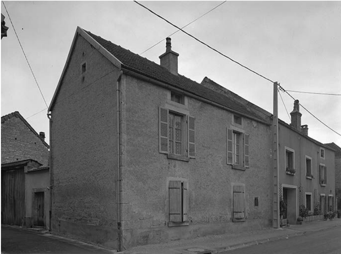
Mur-pignon et façade latérale.
