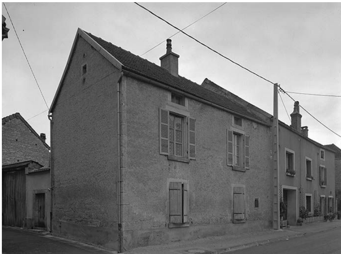
Mur-pignon et façade latérale.
