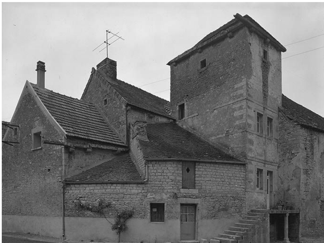
Bâtiments juxtaposés et tour demi-hors-oeuvre.
